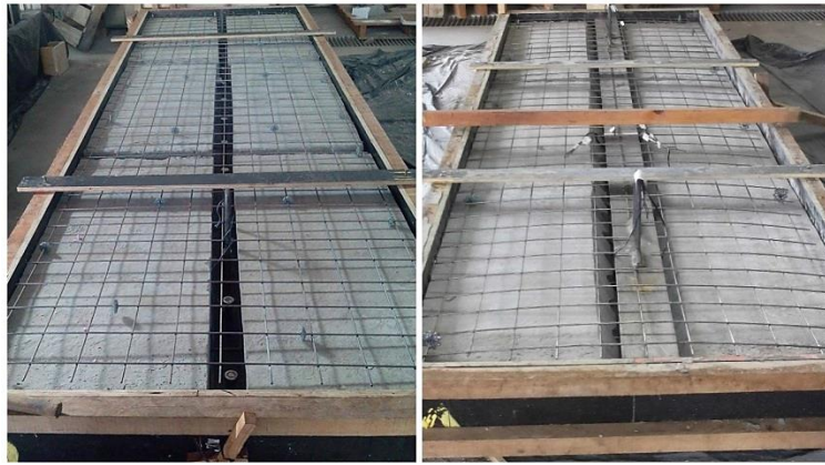
Figura 4.12 – Preparação dos modelos de flexão para concretagem.
