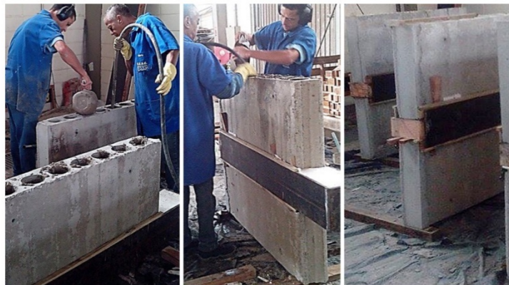
Figura 4.11 – Preparação e concretagem do modelo de push-out .
