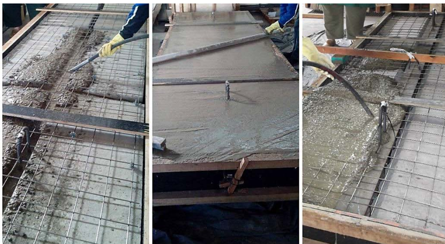
Figura 4.14 – Concretagem, adensamento e nivelamento dos modelos de flexão.
