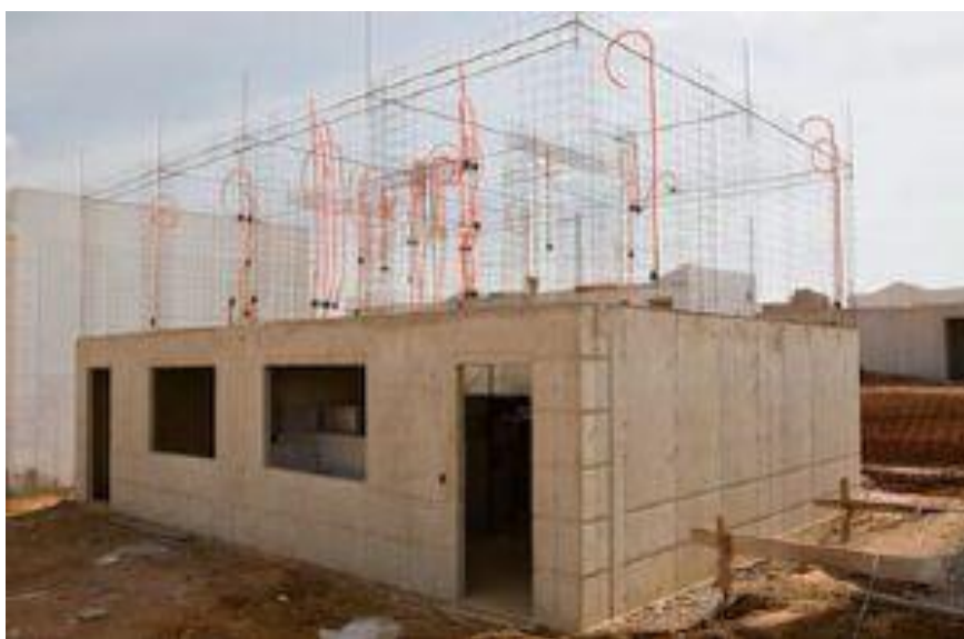
Figura 1.1 – Edificação em parede de concreto e suas instalações (Fonte: Faria, 2009)
