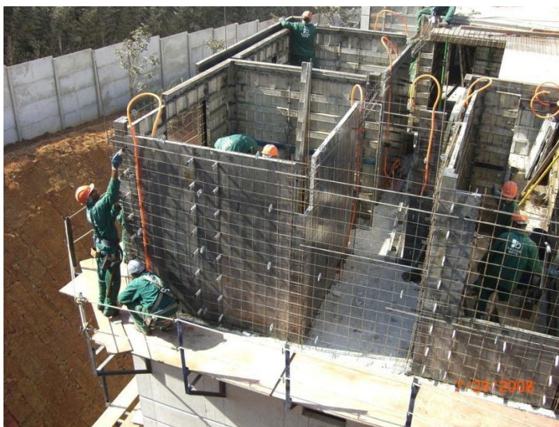
Figura 2.1 – Montagem das paredes (Fonte: www.abcp.org.br )
