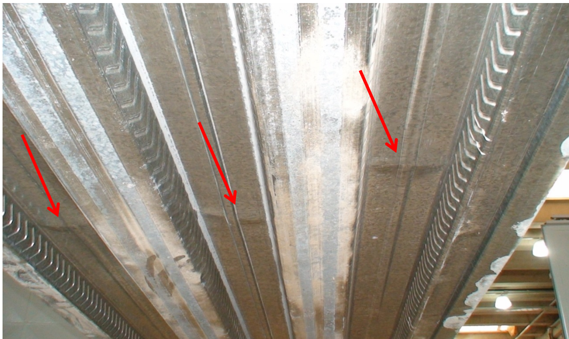
Figura A.13 – Configuração deformada da fôrma de aço no estágio final do ensaio, na região entre as forças aplicadas.
