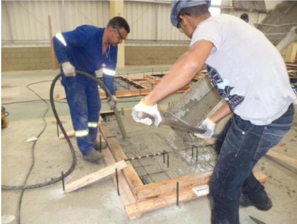
Figura A.2 – Concretagem dos protótipos.
