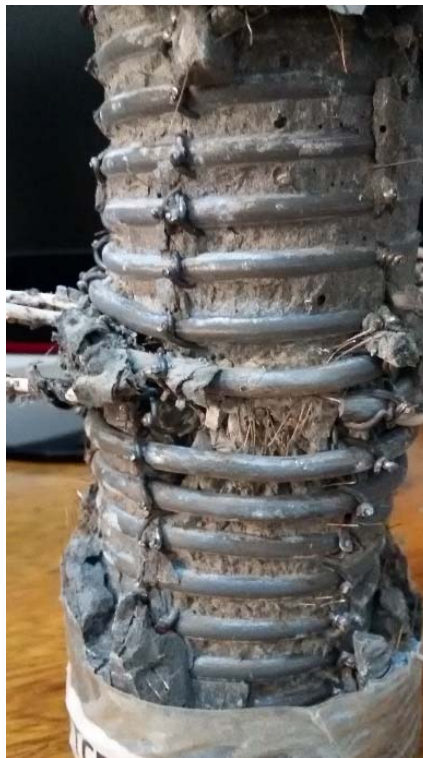
Figura 9.3 – Ruptura da espiral e flambagem da armadura longitudinal
