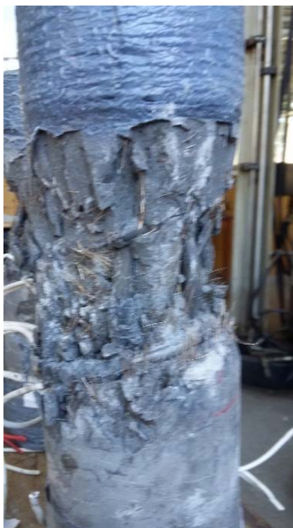
Figura 9.9 – Flambagem das armaduras longitudinais pilar MOD45TCF
