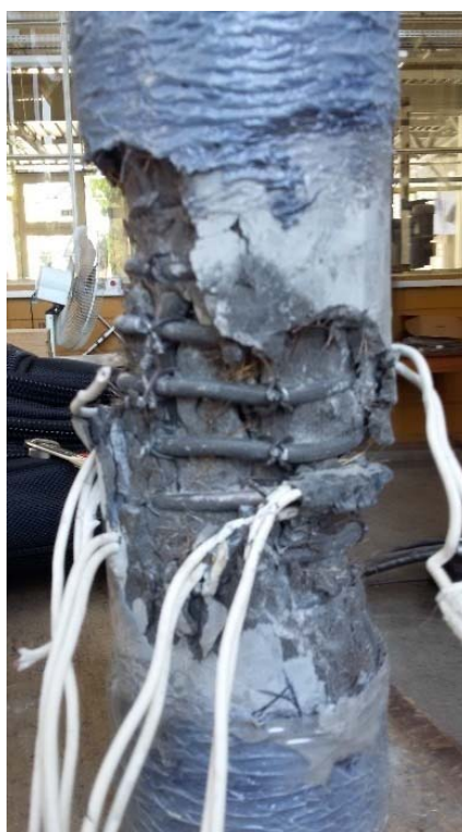
Figura 9.5 – Pilar MOD15TCF após término do ensaio de compressão centrada
