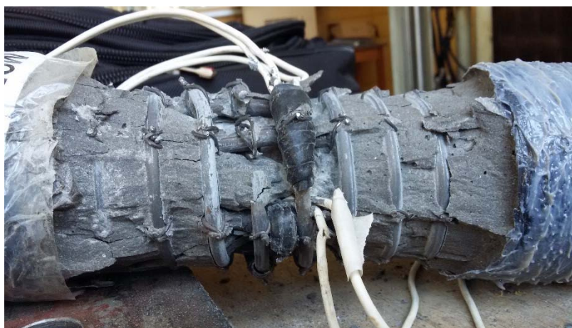
Figura 9.8 – Ruptura da espiral e flambagem das armaduras longitudinais do pilar MOD15TSF
