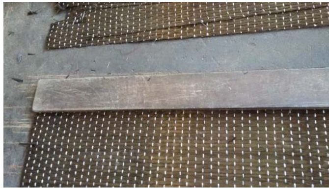
Figura 4.26 – Corte dos tecidos de fibra de carbono
