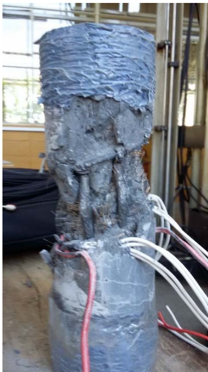
Figura 9.12 – Pilar MOD60ICF após a ruptura
