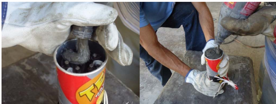
Figura 4.23–Concretagem dos pilares
