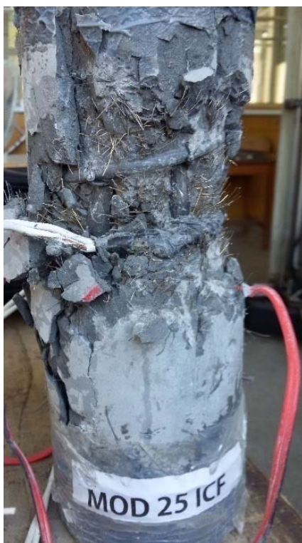
Figura 9.7 –Flambagem das armaduras longitudinais do pilar MOD25ICF
