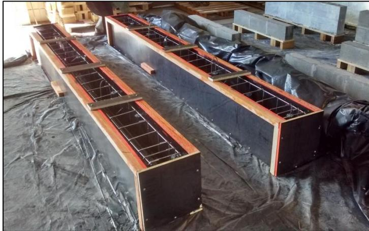
**Figura 17** - Da esquerda à direita, formas de madeira com as armaduras das vigas V02 e V01, respectivamente posicionadas, à espera da concretagem. Fonte: Autoria própria.
