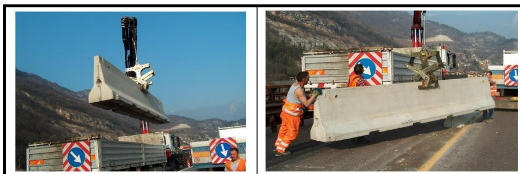
Figura 1.8 – Processo de montagem de barreiras pré-fabricadas de concreto. (Serguvia, 2012).
