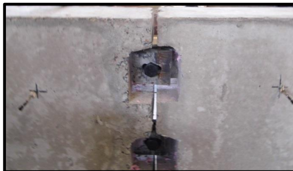
Figura 4.4 – Padrão de encaixe do conector BNJ-M
