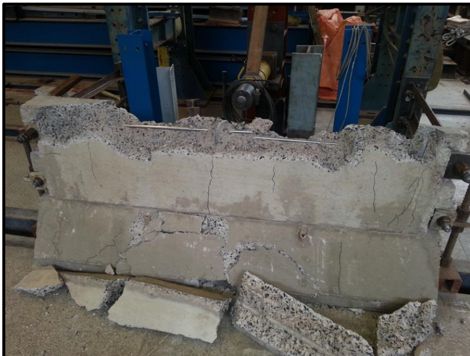
Figura 4.27 – Linhas de ruptura na barreira BNJ-NY
