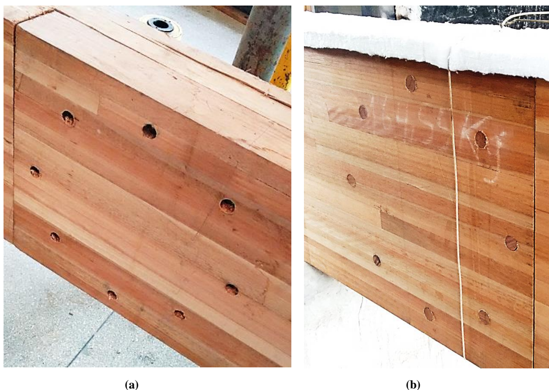
Figura B.6: Ligação: (a) sem preenchimento; (b) com preenchimento com cavilha de madeira.
