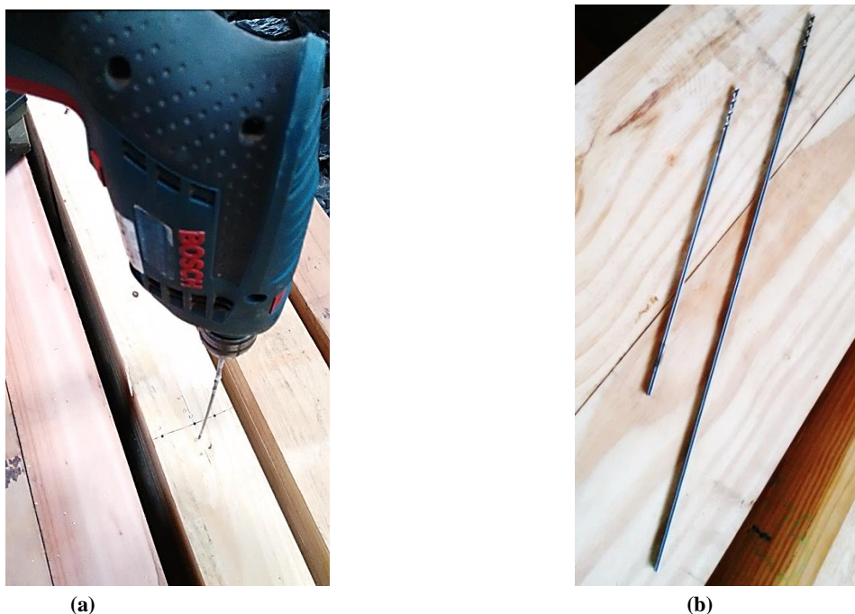
Figura 3.25: Posicionamento dos termopares: (a) furos na face superior (b) Broca com prolongadores.
