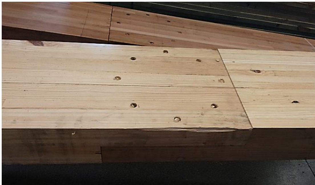
Figura B.10: Detalhe da ligação finalizada.
