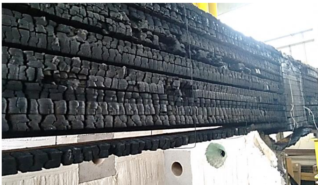
Figura C.7: Vigas de Lyptus no interior do forno depois de removida a tampa.
