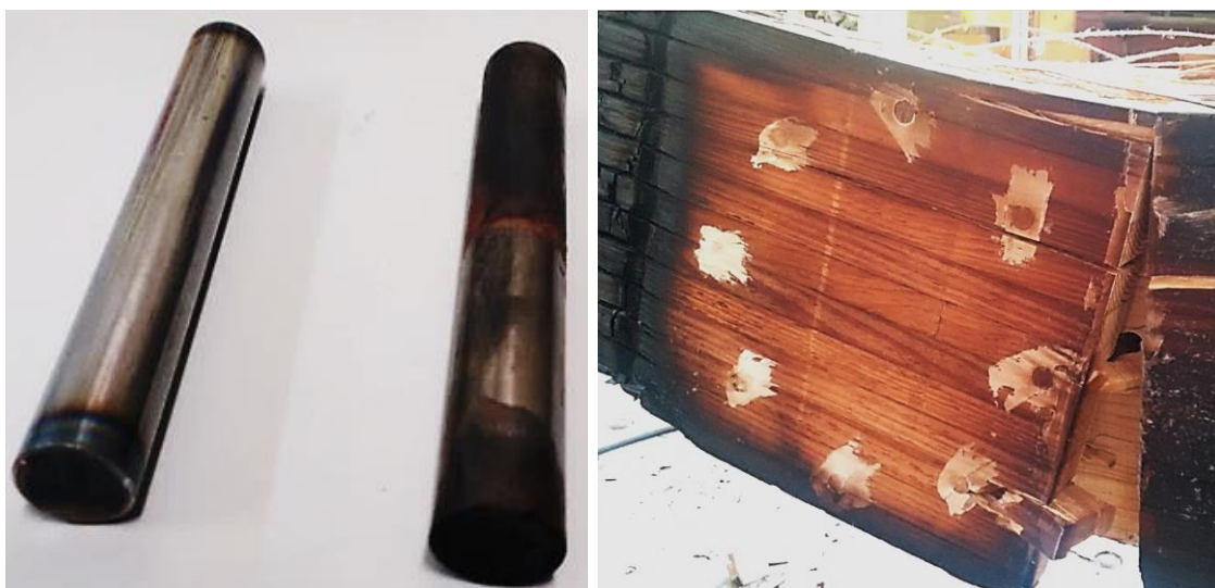
Figura 3.74: Ligação: (a) Pino metálico; (b) região de ligação após a ruptura.
