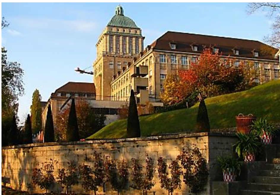
Figura 2.1: Cobertura da torre construída no antigo Hygiene Institute Zürich, Suíça. Fonte: Wikipédia 1
