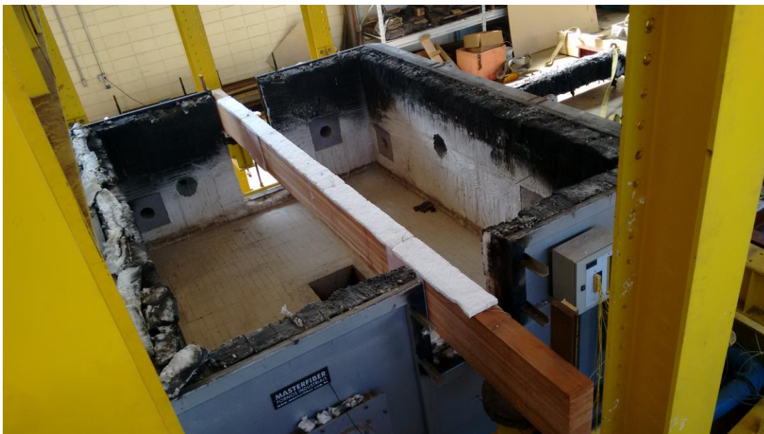
Figura B.12: Vista superior dos elementos finalizados com a conexão.
