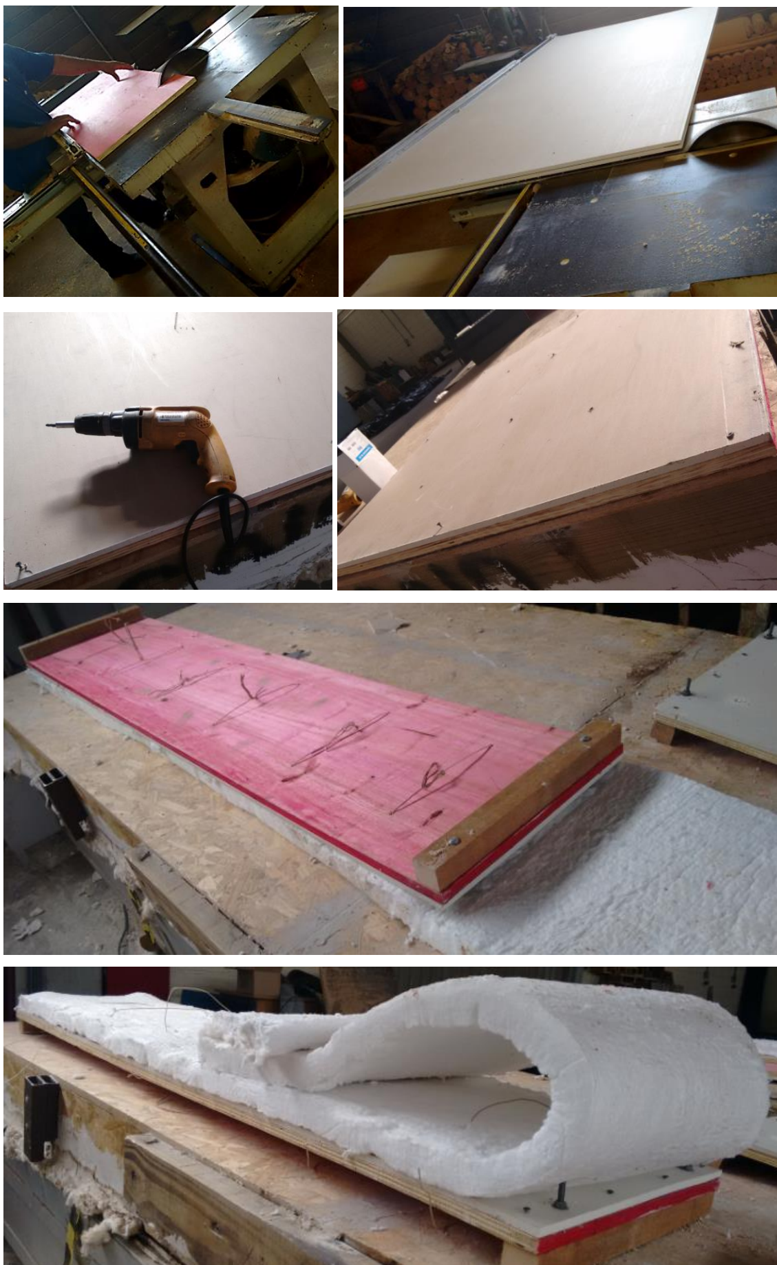
Figura 3.32: Etapas de montagem da estrutura de isolamento.
