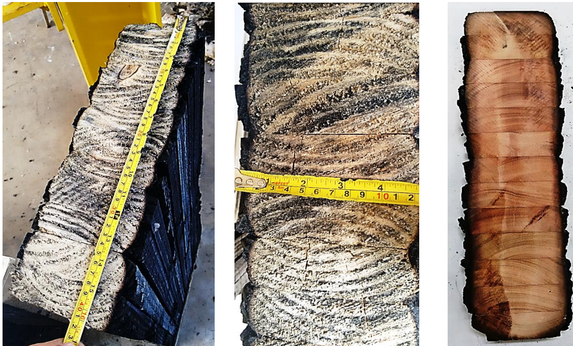
Figura 3.37: Avaliação da seção transversal residual.
