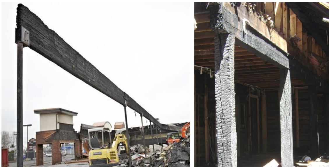
Figura 2.6: Estruturas de madeira afetadas por temperaturas elevadas. Fonte: Website AV Studio 3
