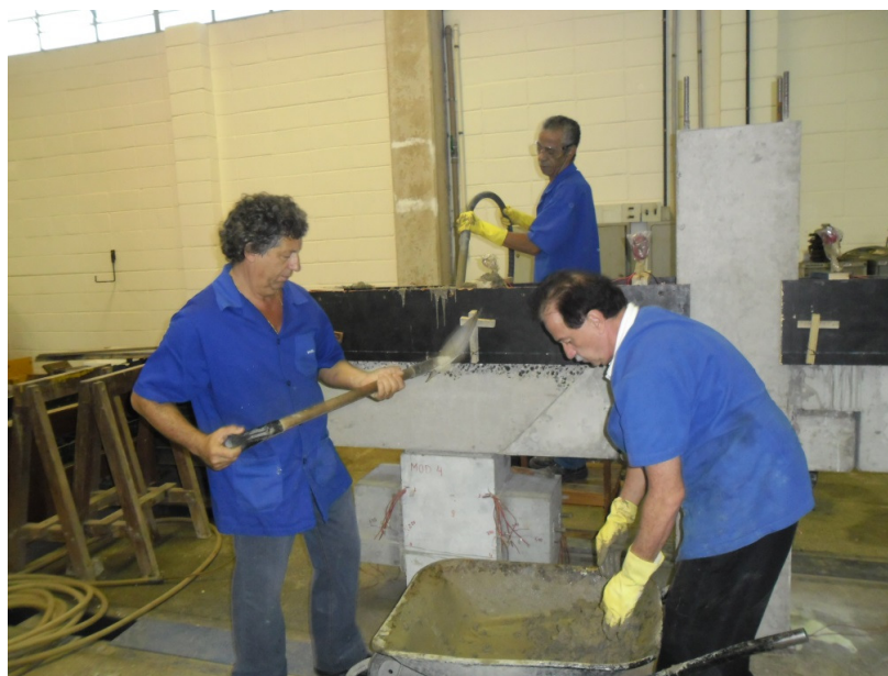
Figura 3.60 – Concretagem da viga
