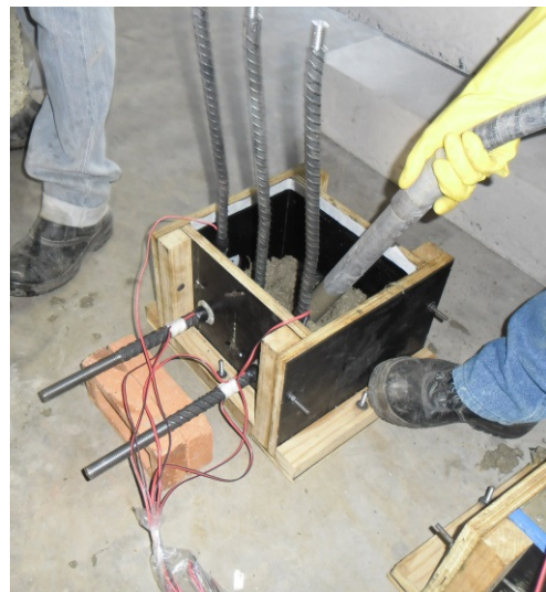
Figura 3.39 – Moldagem do Consolo
