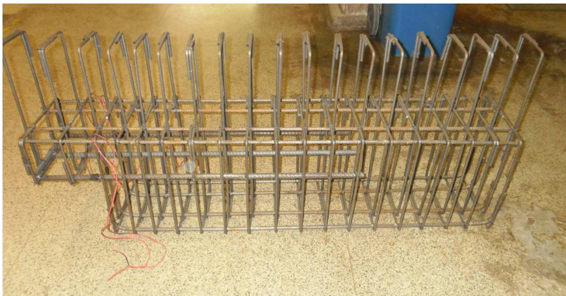
Figura 3.31 – Foto da armadura da viga
