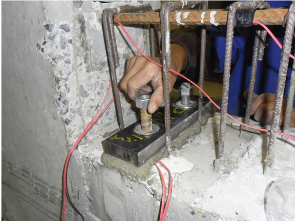
Figura 3.56 – Posicionamento das chapas dos chumbadores
