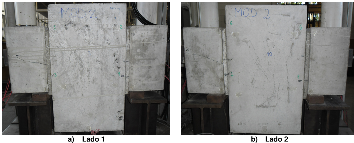
Figura 4.11 – Fissuração do Modelo 2
