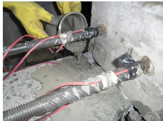
Figura 3.49 – Grauteamento dos Furos
