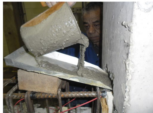
Figura 3.59 – Grauteamento das barras de Continuidade
