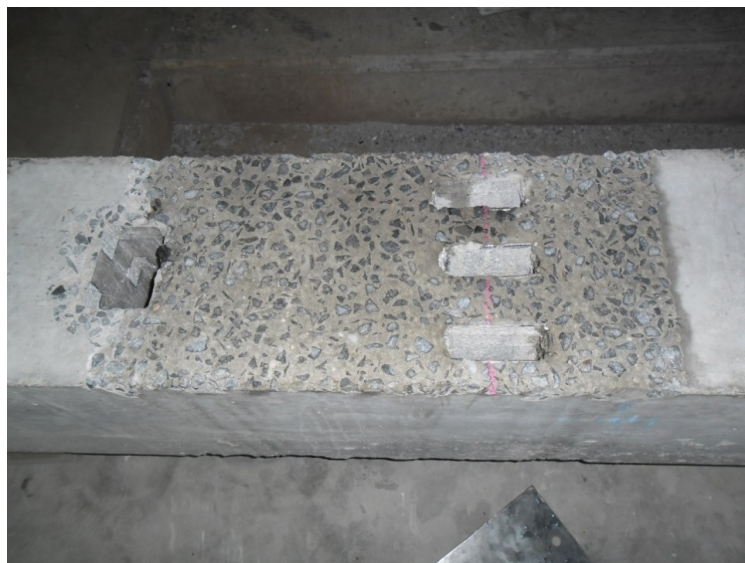
Figura 3.43 - Detalhe dos furos e tratamento da superfície
