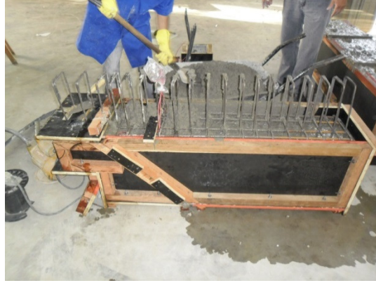
Figura 3.37 – Concretagem do restante da viga
