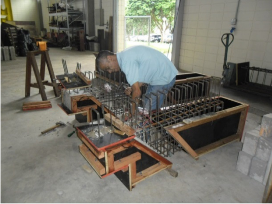
Figura 3.36 – Preparação das fôrmas
