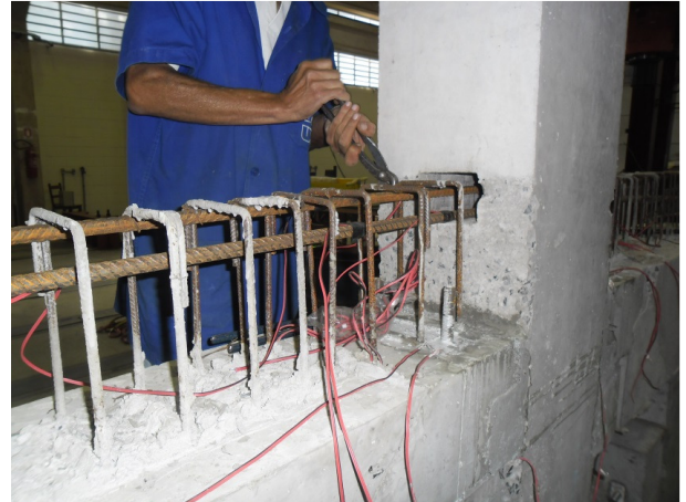
Figura 3.57 – Posicionamento das barras de continuidade
