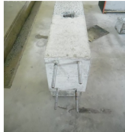
Figura 3.42 – Detalhe da armadura
