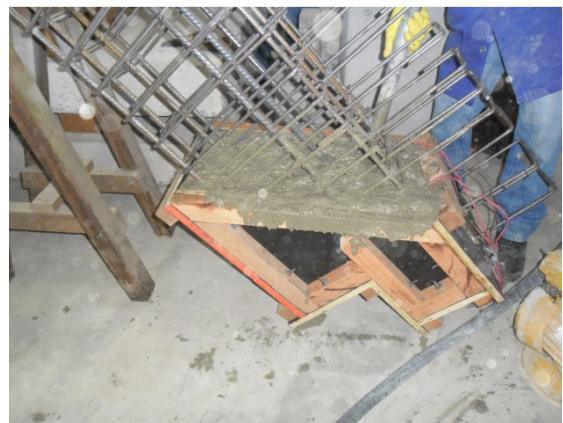
Figura 3.35 – Dente da Viga concretado
