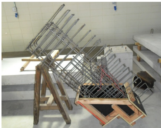
Figura 3.34 – Fôrma e armadura prontas para concretagem
