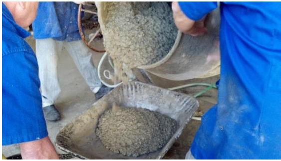
Figura 3.9 – Produção de concreto
