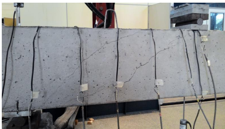
Figura 7.2 – Fissuração da viga V50 SR
