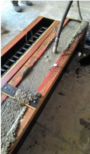
Figura 5.8 – Concretagem de vigas
