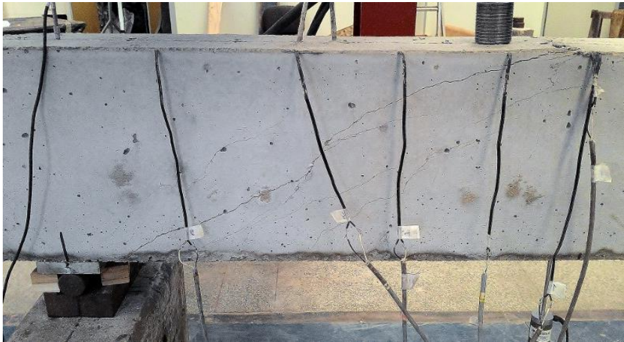
Figura 6.3 – Ruptura da viga V90 SR
