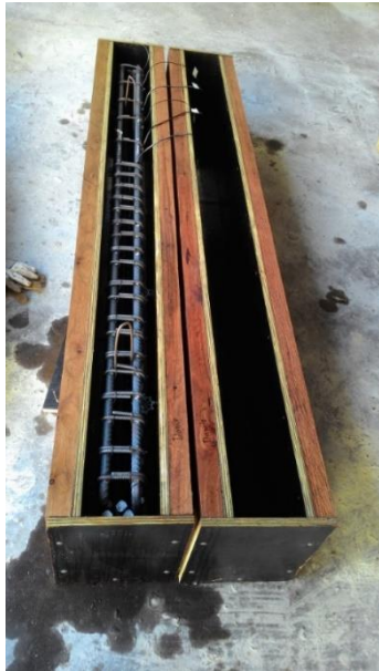
Figura 5.6 – Armadura e forma das vigas
