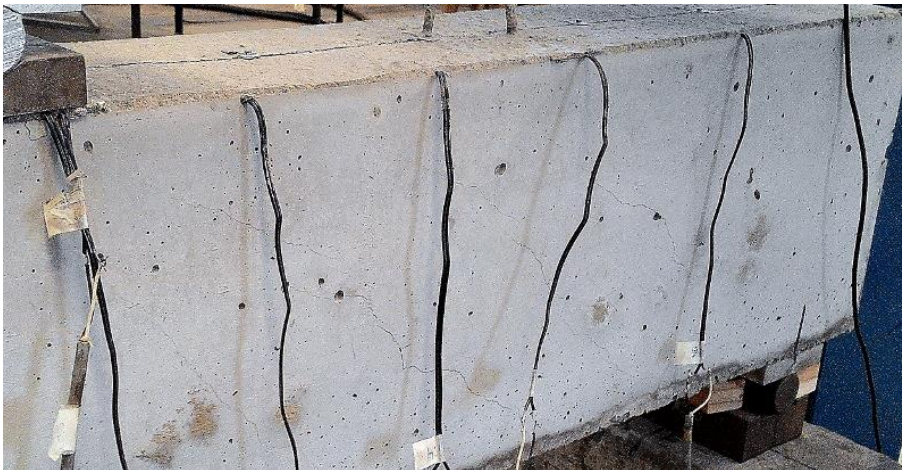
Figura 6.2 - Fissuração da viga V90 SR
