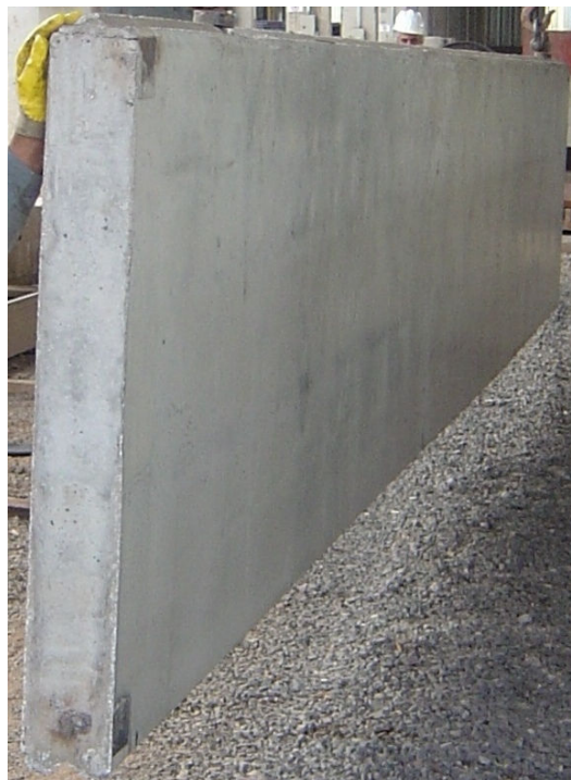
Figura 2: Painel de fechamento de Concreto Leve com EPS (PINHEIRO, 2016)
