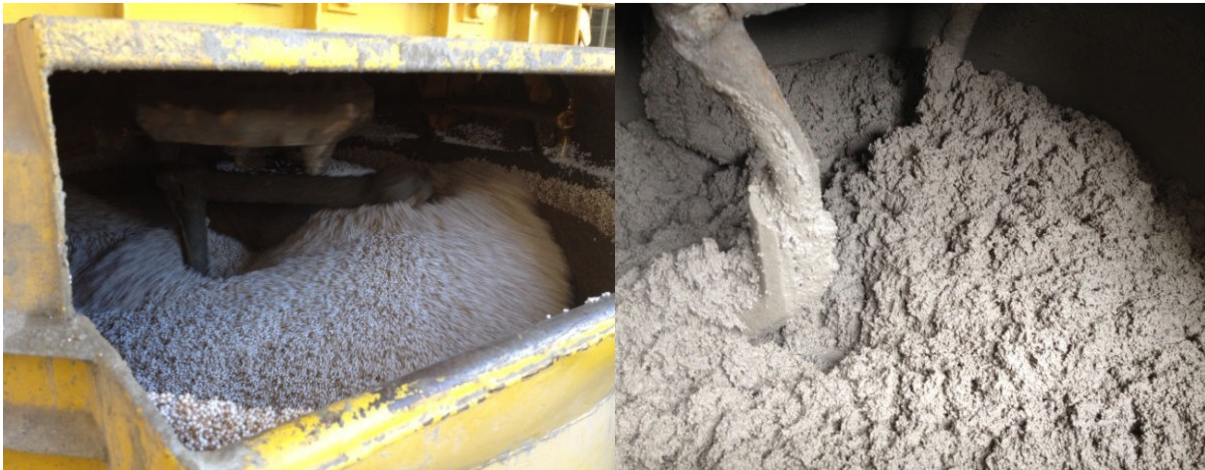
Figura 12: Traço confeccionado no misturador com capacidade de 350 litros
