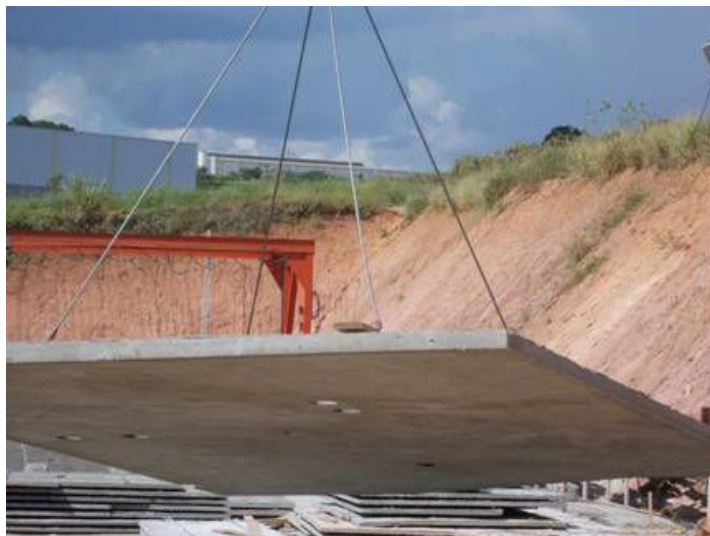
Figura 1: Laje de concreto leve com EPS durante içamento (KERBAUY, 2011)
