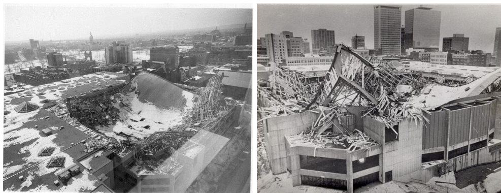
Figura 2: Colapso da cobertura do Hatford Coliseum, 1978. Fonte: Connecticut Historical Society (2014).
