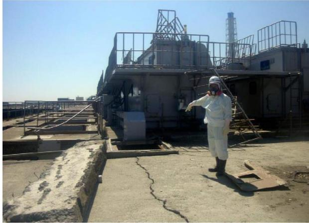
Figura 1.4 Macro fissura próxima a um reator da usina nuclear de Fukushima no Japão em 2011
