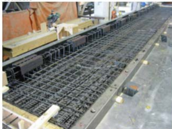
(d) término da montagem da armadura com estribos fechados
