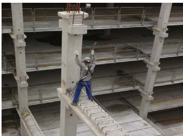
(c) montagem de viga para apoio interno;
