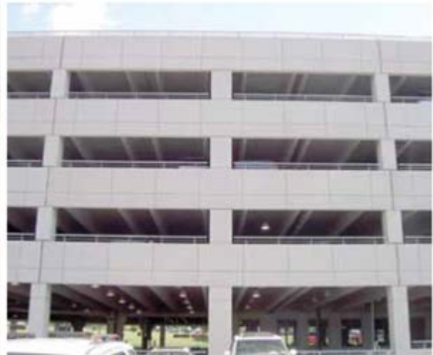
(b) pilares falsos podem ser adicionados no meio do vão para modificar o impacto visual.
