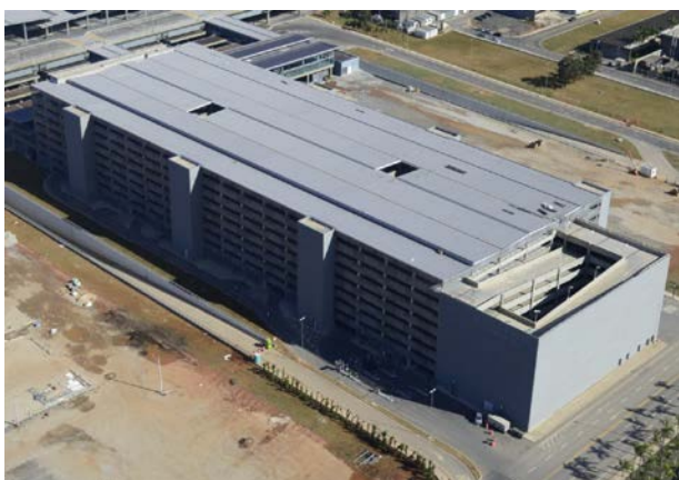
(a) edifício pronto para funcionamento;
