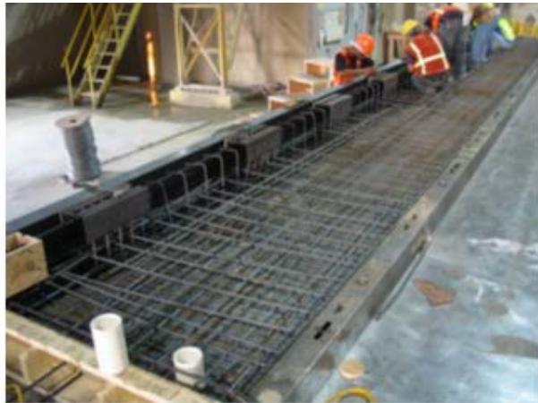
(b) término da montagem da armadura sem estribos fechados
