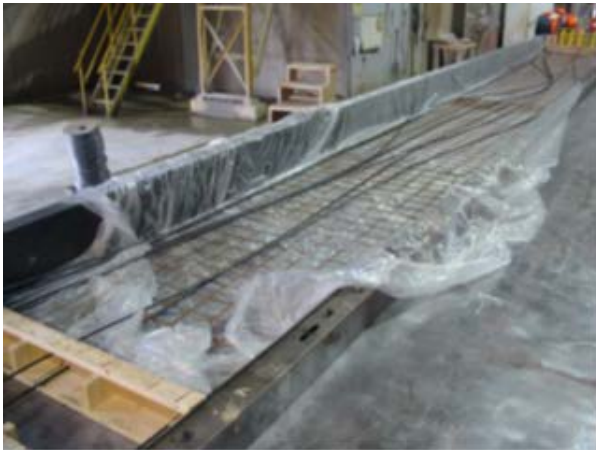
(a) início da montagem da armadura sem estribos fechados
