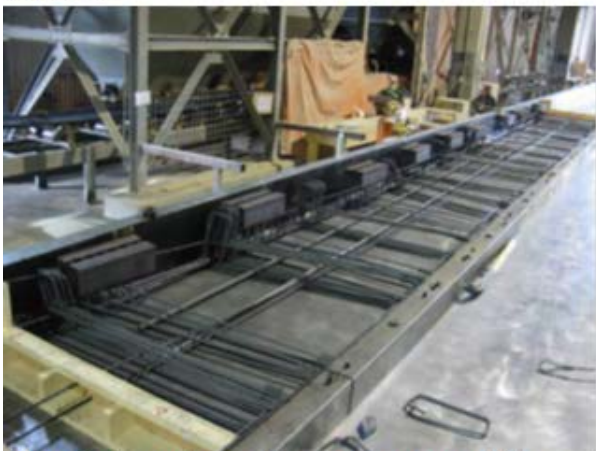
(c) início da montagem da armadura com estribos fechados
