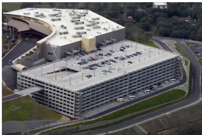
(a) prédio em funcionamento, pode ser notado que o acesso aos pavimentos é realizado por rampas internas;
