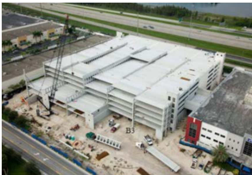
(a) foto pré-incidente que mostra o progresso da obra em 25/09/2012;
