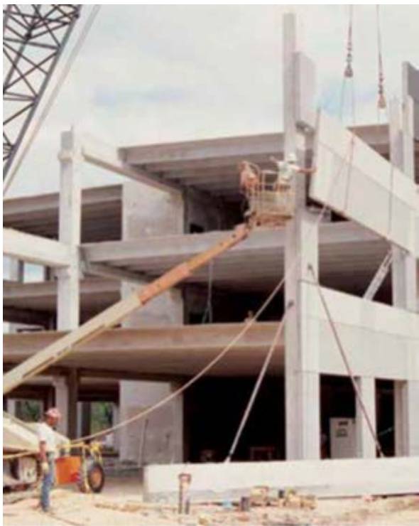
(a) detalhes da montagem;
