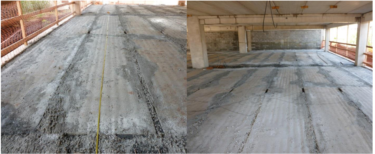
Figura 31 - Pavimento no ensaio dos painéis com chave de cisalhamento
