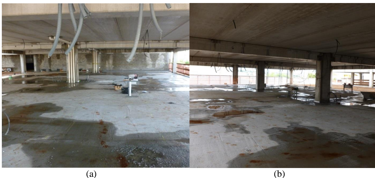
Figura 35 - Pavimento com capa estrutural ensaiado - (a) vista da laje direita (b) vista da laje esquerda
