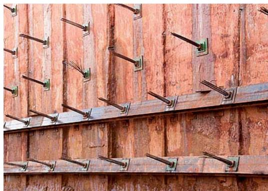
Figura 1.2 - Cortina atirantada para contenção do solo.
