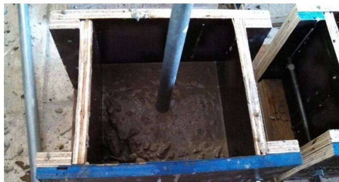
Figura 4.6 – Processo de adensamento do concreto dos blocos
