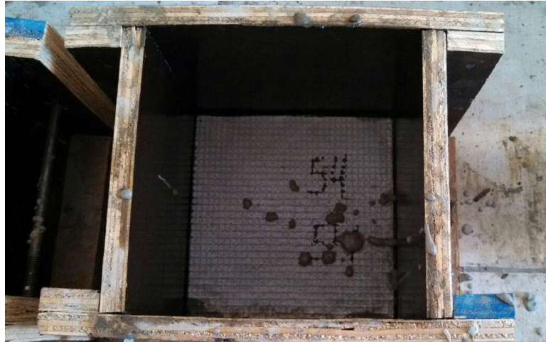
Figura 4.20 – Fôrma para bloco de concreto com almofada inserida antes do lançamento do concreto
