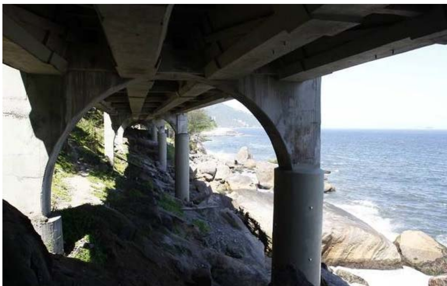
Figura 4.2 - Tabuleiro do Elevado do Joá
