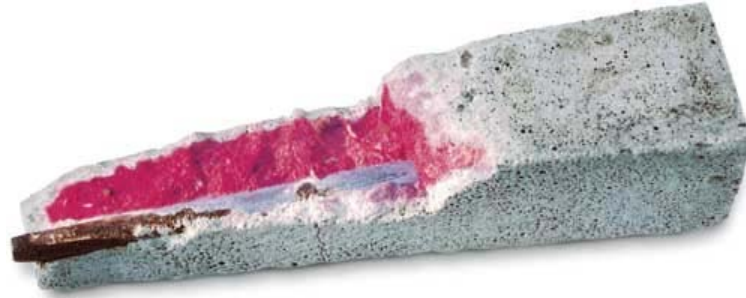
Figura 4.6 - Carbonatação: Indicadores à base de fenofaleína reagem e tornam-se incolores na zona carbonatada e assumem uma cor vermelho-carmim na região alcalina Fonte: http://www.structuremag.org/article.aspx?articleID=377
