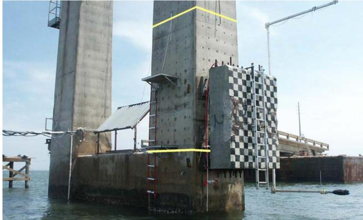
**Figura 2.24** – Pilar 1 e bloco de impacto (FERRARO et al., 2013)
