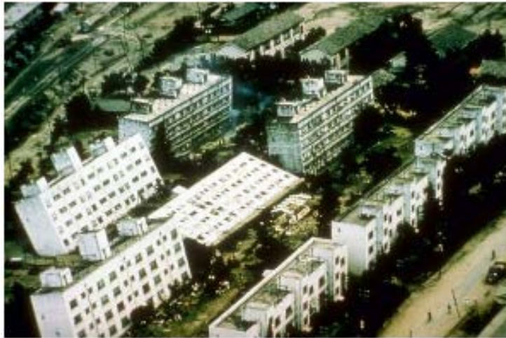
Figura 8. Liquefação dos solos no Terremoto de Niigata Japão 16 de Junho de 1964. [USGS U.S GEOLOGICAL SURVEY, Disponível em: < http://earthquake.usgs.gov/earthquakes/world/events/1964_06_16.php >. Acesso em: 21/04/2013]
