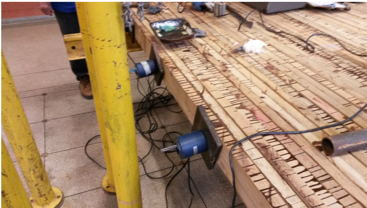
Figura 53 - Células de carga antes da colocação das ancoragens passivas.
