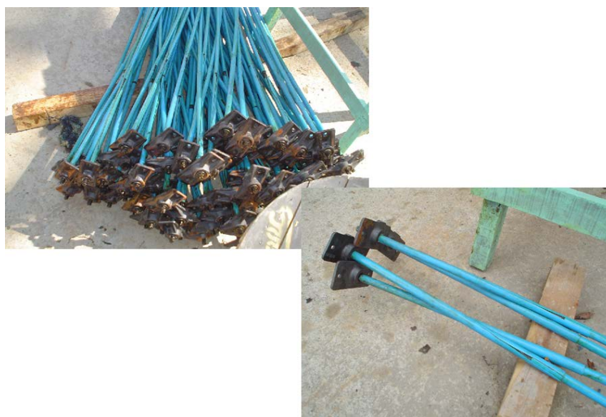
Figura 109 - Cabos com armadura passiva montada. Fonte: VASCONCELOS (2013).
