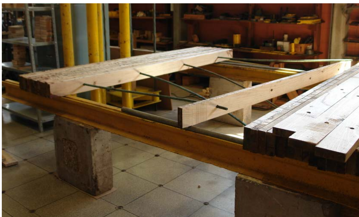
Figura 110 - Montagem das lâminas do tabuleiro. Fonte: O AUTOR (2014).
