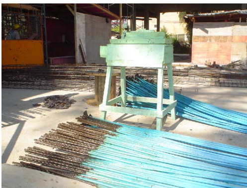
Figura 105 - Cabo pronto para receber a armadura passiva. Fonte: VASCONCELOS (2013).
