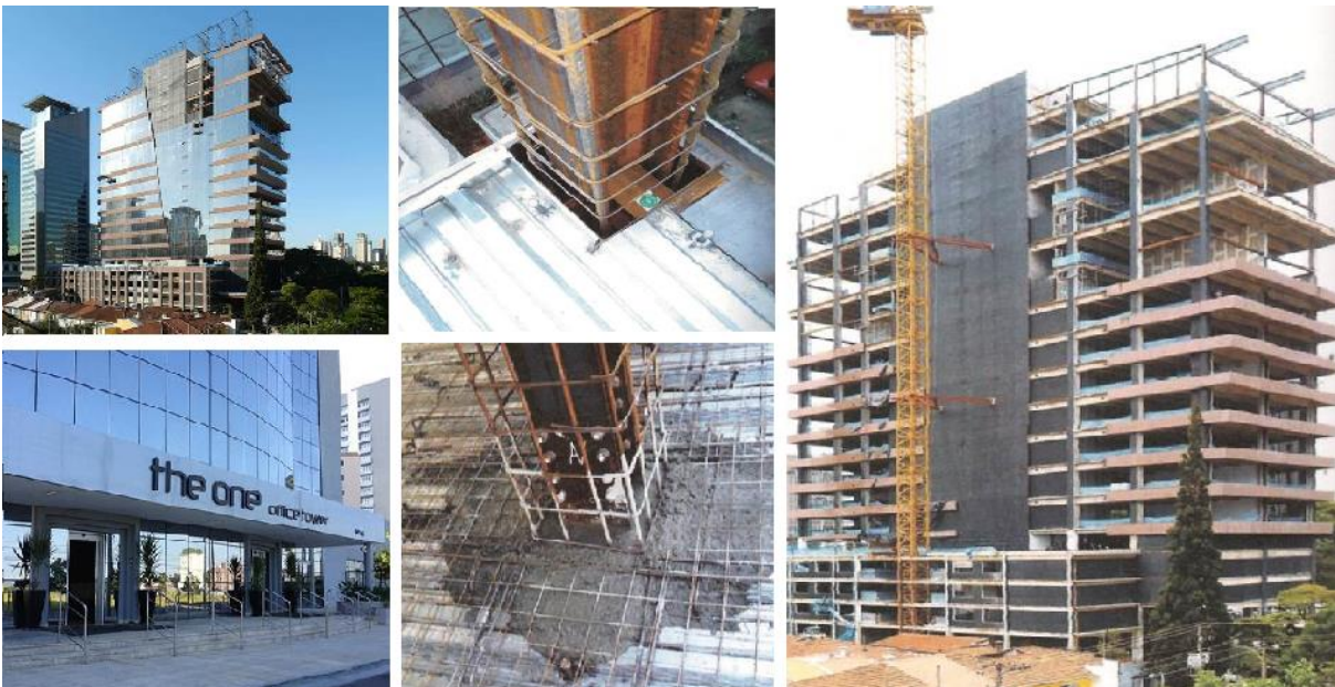
Figura 1.2 – Edifício The One (DIAS, 2014).
