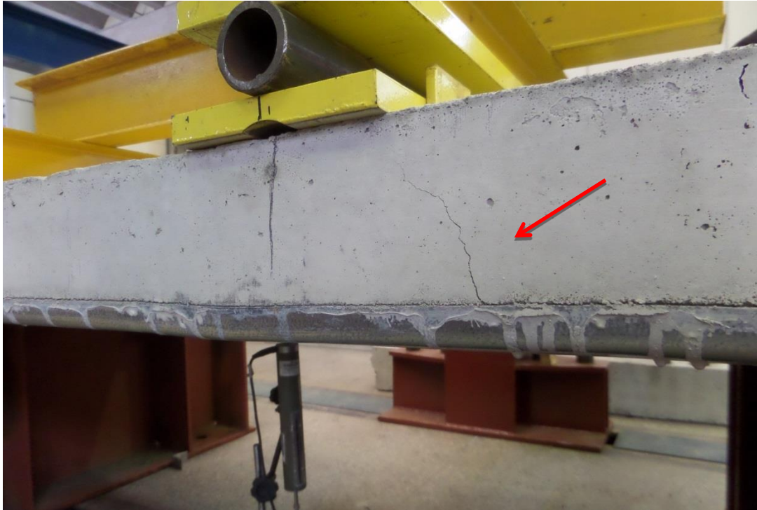
Foto A.11 – Aspecto típico da fissura na região da força aplicada, após o deslizamento
