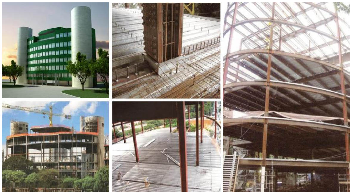
Figura 1.3 – Edifício Multifuncional Allianz Arena (DIAS, 2014).
