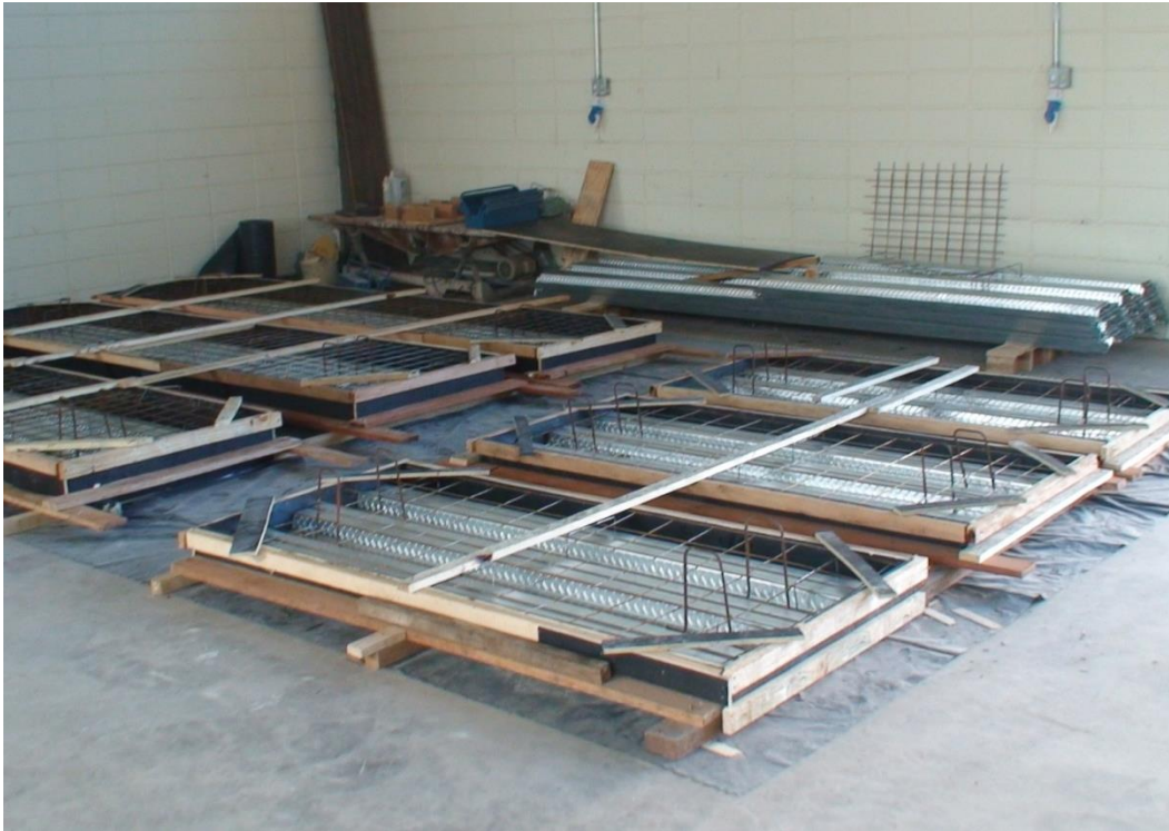
Foto A.1 – Protótipos preparados para concretagem
