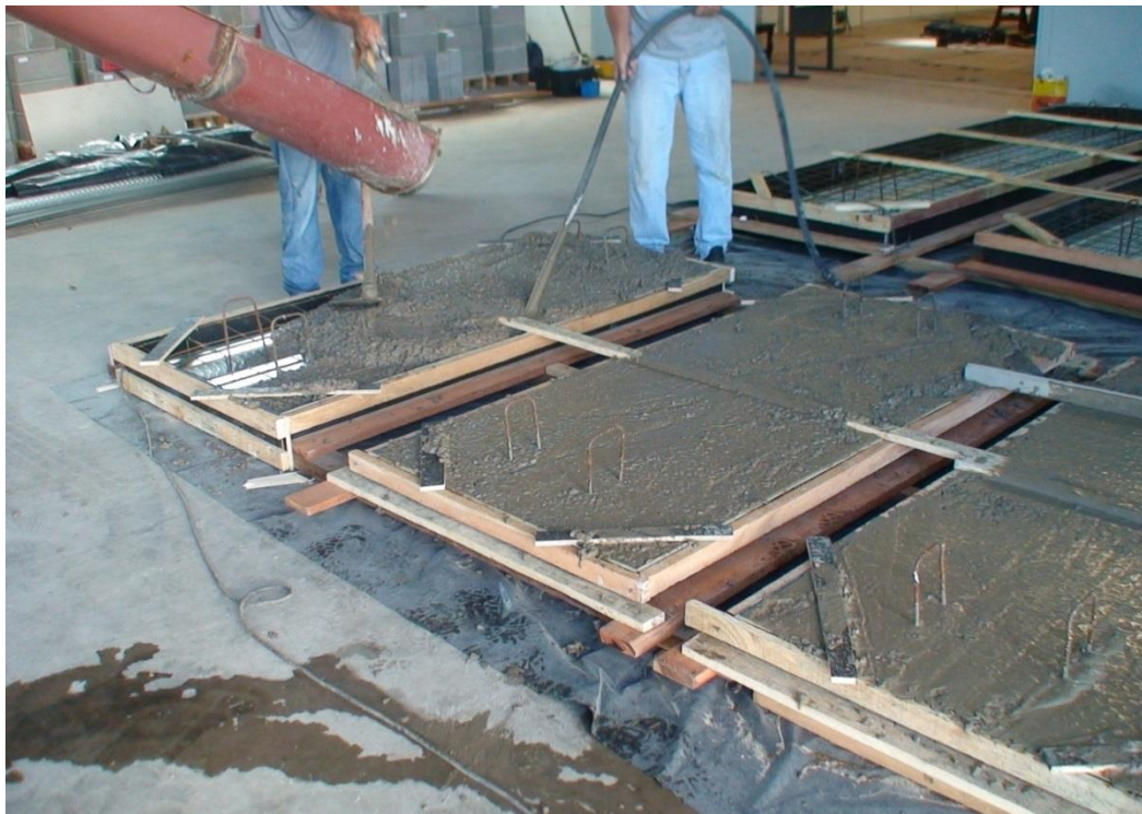
Foto A.2 – Concretagem dos protótipos
