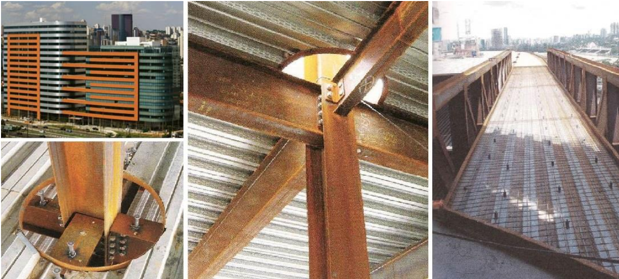
Figura 1.1 – W Torre Nações Unidas (DIAS,2014).
