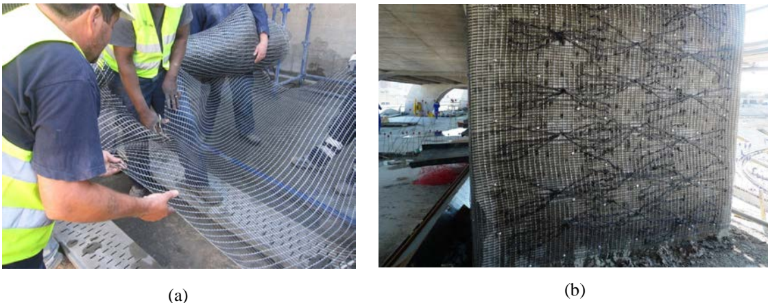
(a) (b) Figura 3.3 – Construção do Maracanã – Uso de malhas de fibras de carbono em grandes estruturas de concreto. Fonte: COSTA (2013).
