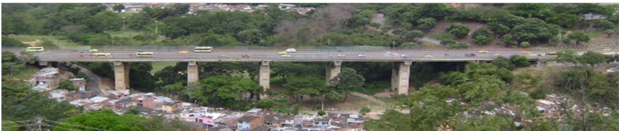
Figura 4-7 Fotografia da ponte Garcia Cadena.
