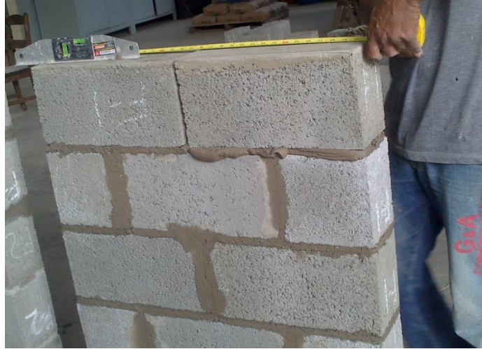
Figura 4.32 – Assentamento das fiadas superiores verificando-se o nível, o prumo e a planeza (Fonte: autor)
