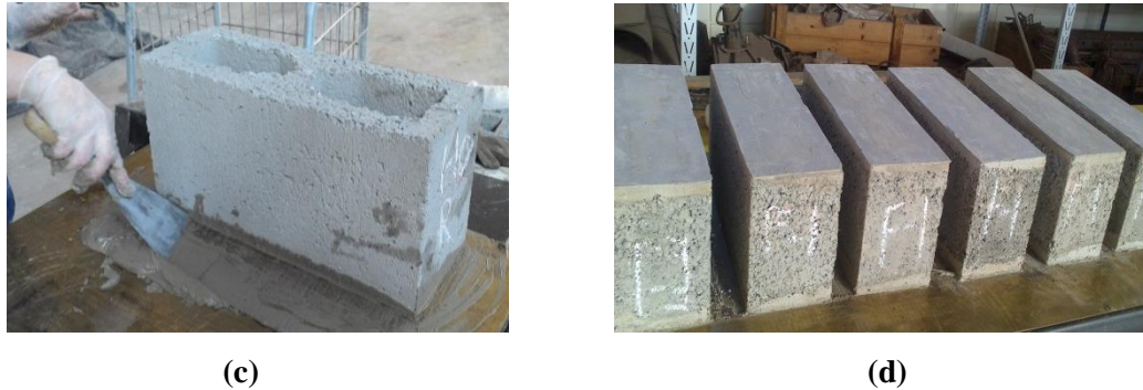
Figura 4.34 – Capeamento dos blocos: (a) distribuição da pasta com espessura de 3 \pm 1 mm, (b) nivelamento do bloco com o auxílio do nível de bolha, (c) retirada do excesso de massa das laterais do bloco e (d) desforma dos blocos após 12 horas (Fonte: autor).
