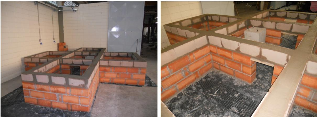
Figura 4.6 – Vista final das alvenarias de sustentação das lajes para os ensaios dinâmicos.
