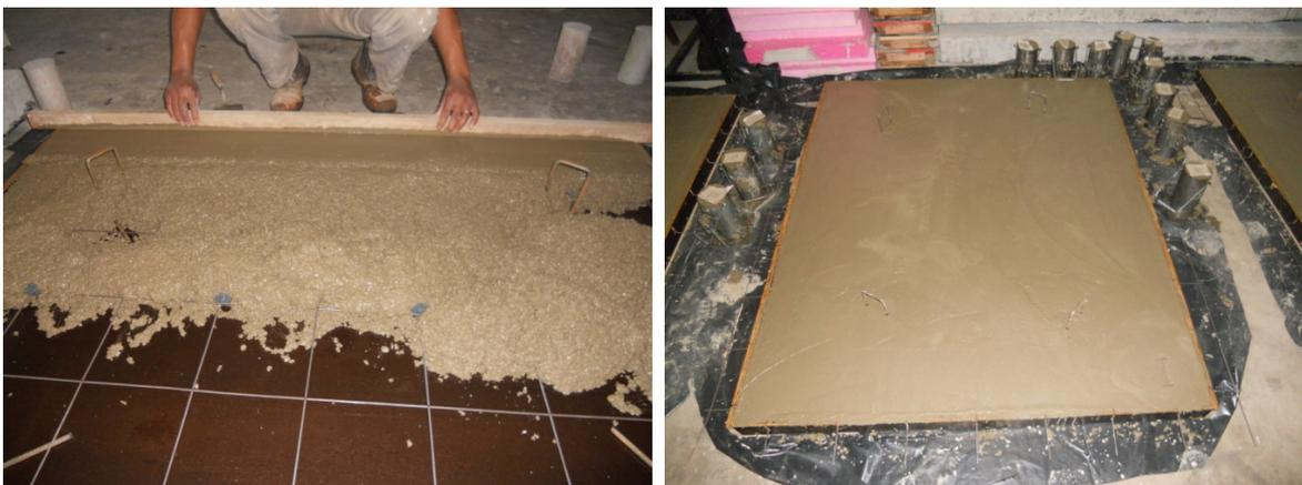
Figura 4.13 – Concretagem das lajes.
