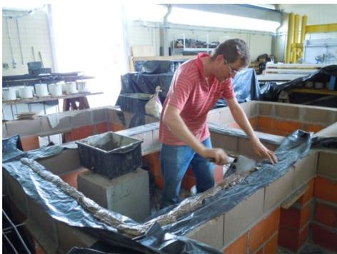
Figura 4.15 – Argamassa magra para apoio da laje sobre a alvenaria.
