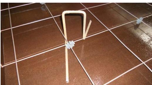
Figura 4.9 – Detalhe de um dos quatro ganchos para içamento.
