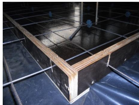
Figura 4.12 – Detalhe das aberturas laterais da forma para passagem da tela.
