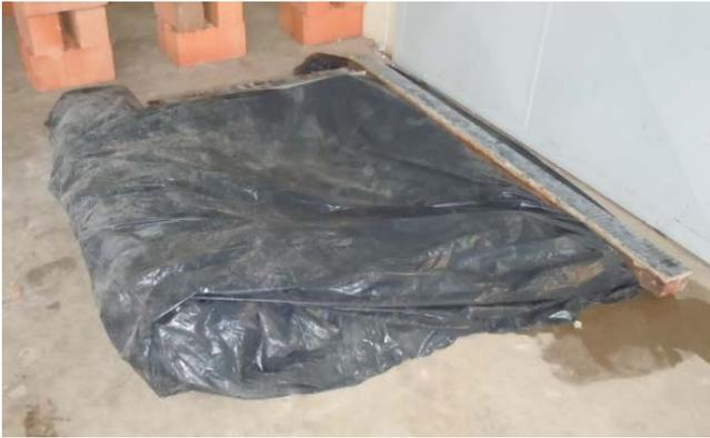
Figura 7.2 – Cura das lajes com auxílio de lona plástica.
