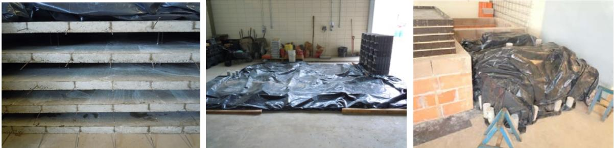
Figura 4.14 – Detalhe do armazenamento e cura das lajes.
