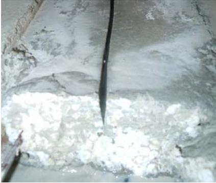
Figura 4.30 – Detalhe do entalhe feito na ligação entre as lajes.
