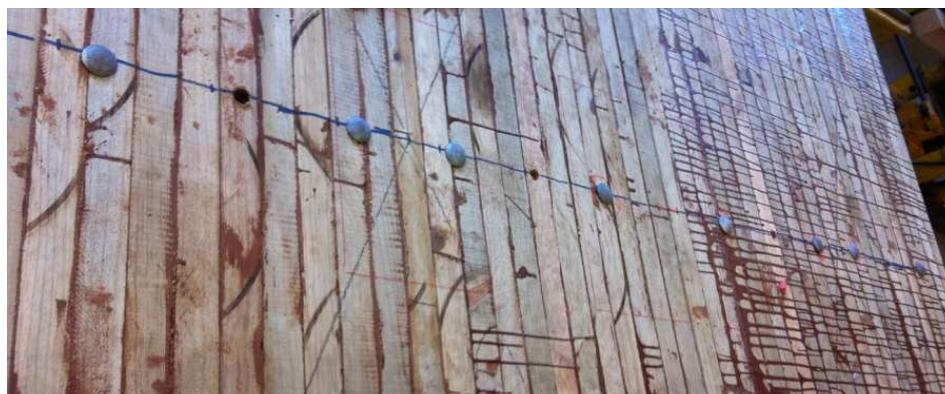
Figura 57 – Parafusos interligando a viga de enrijecimento e o tabuleiro.
