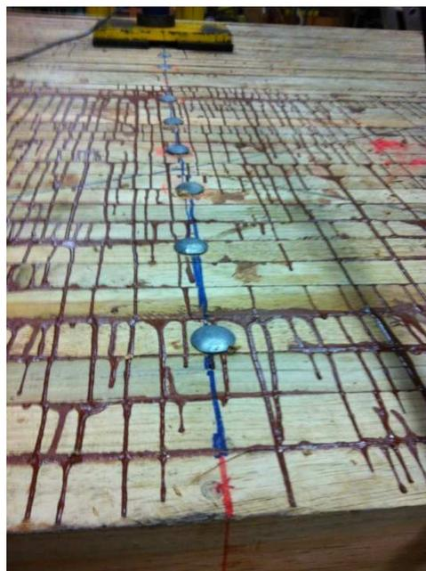
Figura 61 – Detalhe dos parafusos que interligam o tabuleiro à viga de enrijecimento.
