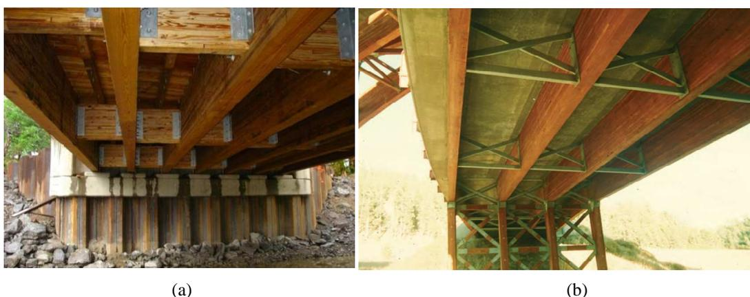
Figura 7 – Vigas longarinas e contraventamentos do tipo (a) diafragma e (b) treliçado.
