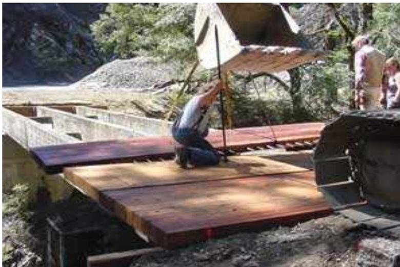
Figura 12 – Montagem dos painéis interconectados por pinos de aço. Fonte: Eriksson et al. (2003)
