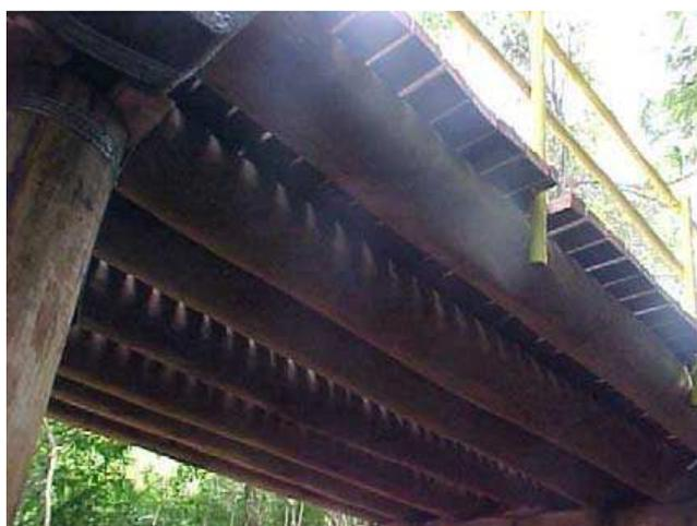
Figura 2 – Ponte em vigas roliças simples. Fonte: (Calil et al., 2006)
