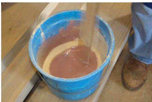
Figura 37 – Preparação do adesivo estrutural.
