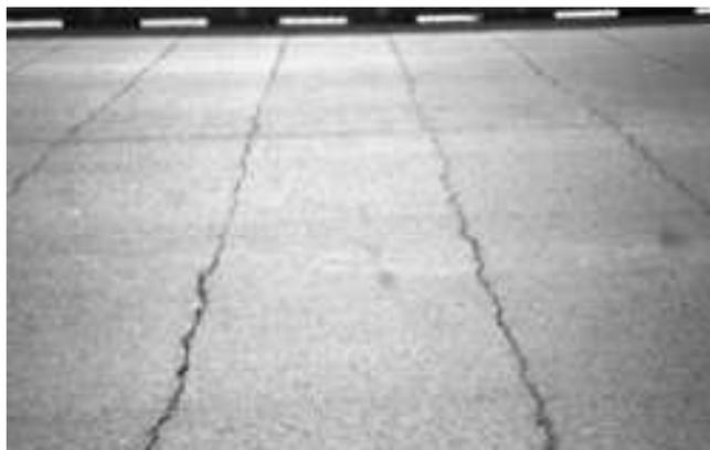
Figura 10 - Trincas no revestimento asfáltico oriundas do deslocamento relativo entre painéis.
