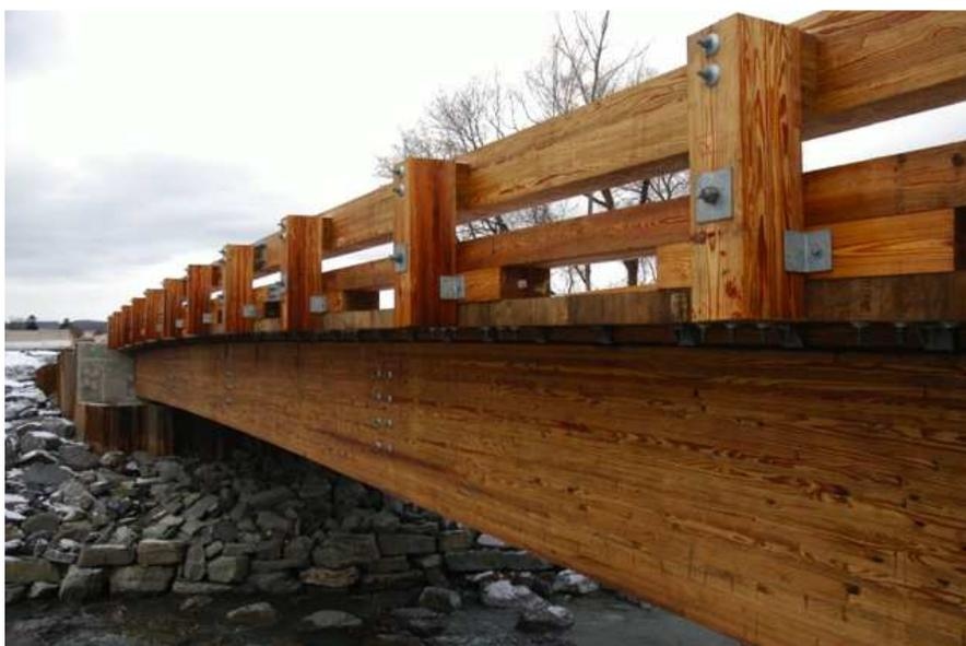
Figura 1 – Ponte em vigas longarinas de MLC. Fonte:
