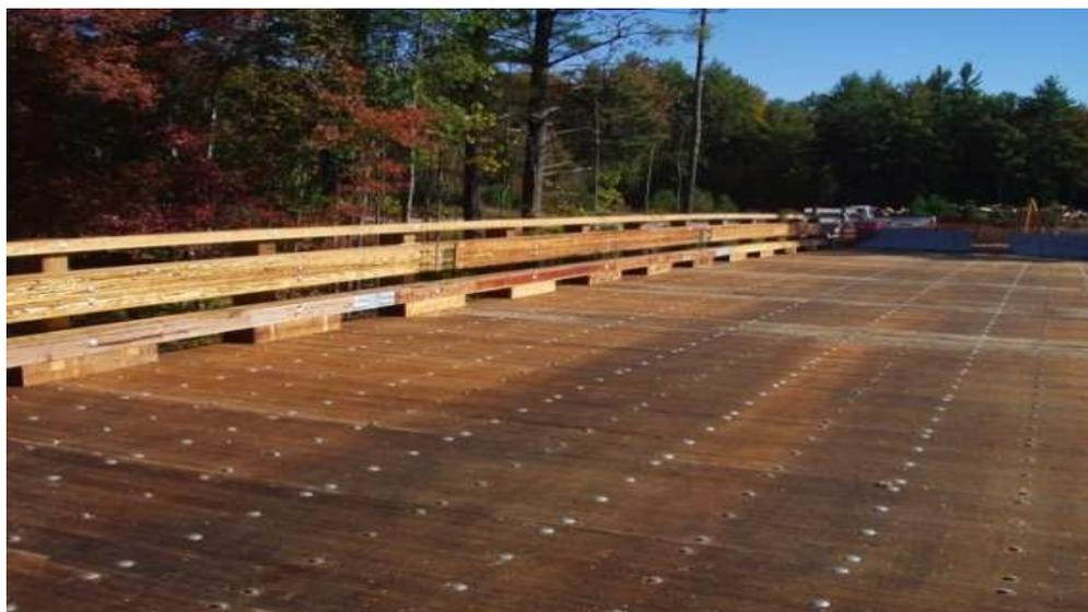
Figura 13 - Tabuleiro em painéis transversais interconectados por vigas de enrijecimento.
