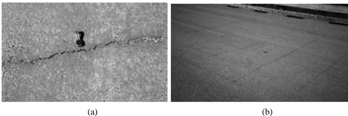
Figura 16 – Fissuras no pavimento sobre o tabuleiro em pontes, devido ao deslocamento relativo entre os painéis transversais de MLC. Fonte: Eriksson et al. (2003)
