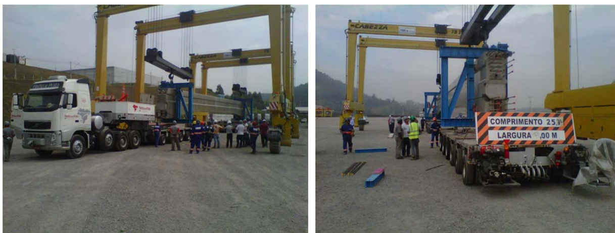
Figura 2-8 – Viga posicionada para transporte
