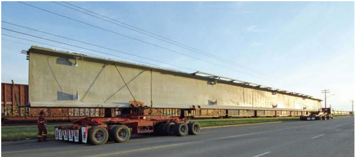
Figura 1-1 - Viga de ponte com 65 m de vão e 2,8 m de altura em Calgary, Canadá
