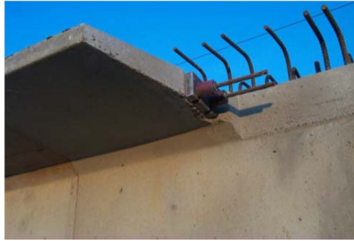
Figura 3-6 – Protensão temporária da mesa superior para melhorar a segurança à instabilidade lateral em transporte 8
