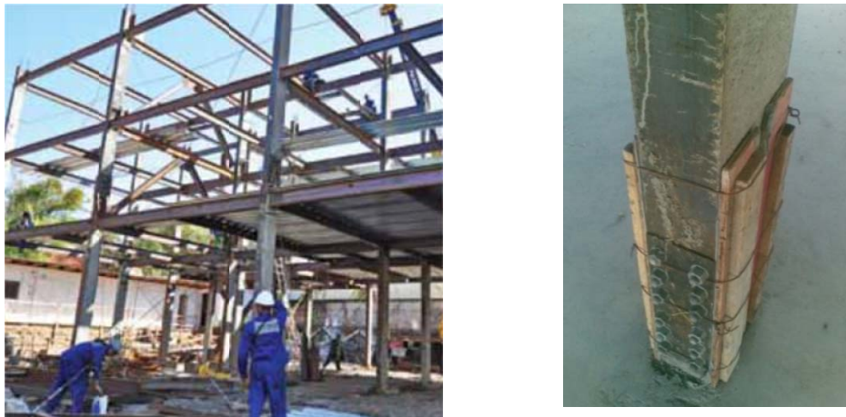
Figura 2.16 – Concretagem interrompida na região da ligação. (ARQUITERUTA & AÇO, 2013)
