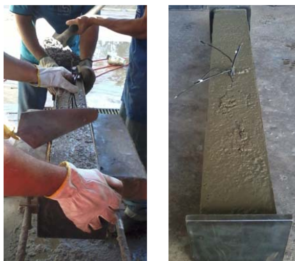
Figura 4.10 – Detalhes da concretagem
