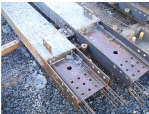
Figura 1.3 – Concretagem dos pilares mistos na posição horizontal (informação pessoal) 1
