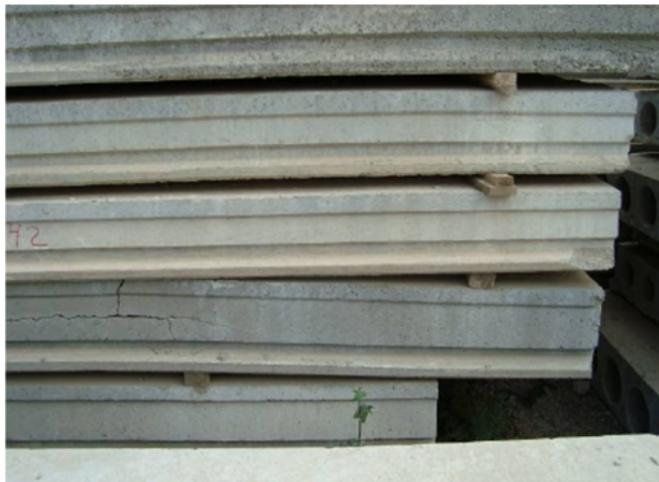
Figura 2.18 – Empilhamento das lajes alveolares com calços desalinhados resultando nas fissuras (PETRUCELLI, 2009)
