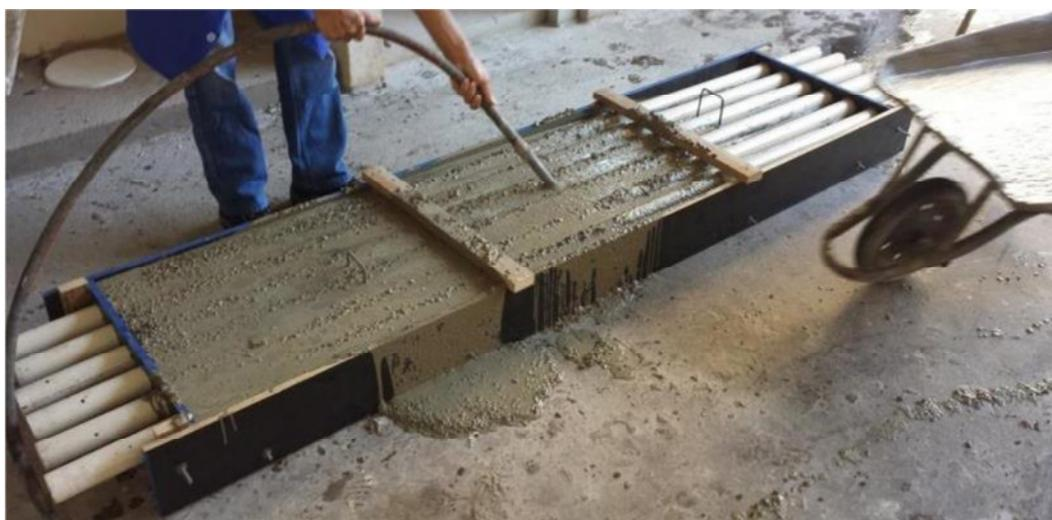
Figura 5.12 – Concretagem do primeiro painel alveolar
