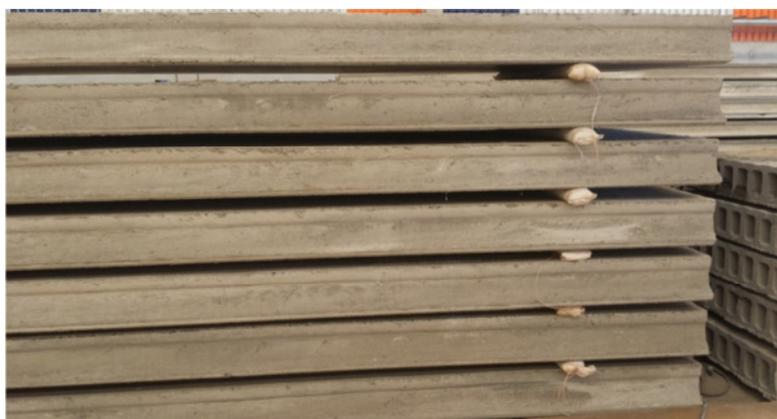
Figura 2.17 – Empilhamento das lajes alveolares com calços alinhados
