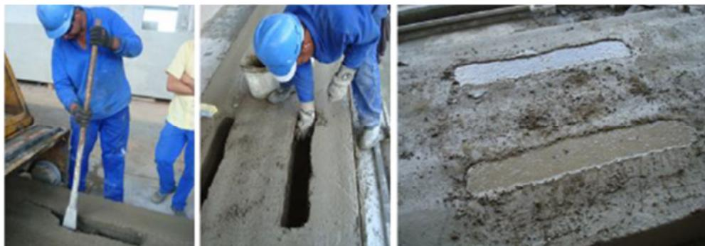
Figura 2.10 – Corte realizado, tamponamento e preenchimento do alvéolo com concreto
