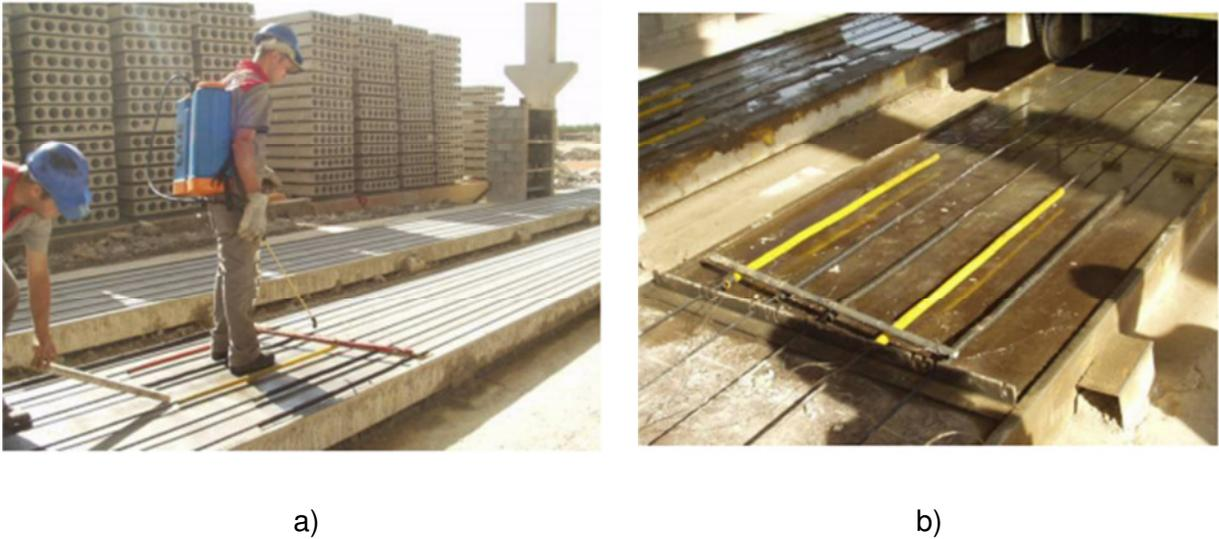
Figura 2.4 – a) Aplicação do desmoldante com pulverizador; b) proteção das cordoalhas ao aplicar o desmoldante
