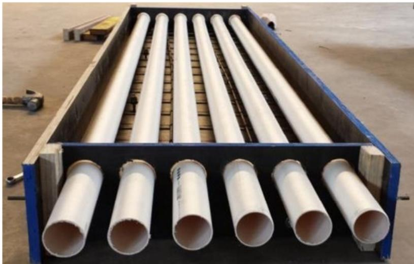
Figura 5.11 – Fôrma montada para o painel alveolar
