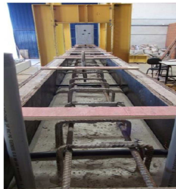
c) Concretagem da capa da viga
