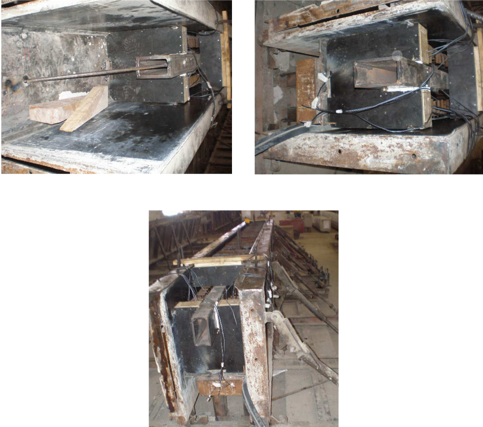
Figura 3.20 – Montagem da fôrma e armação da viga pré-moldada – Parte II.
