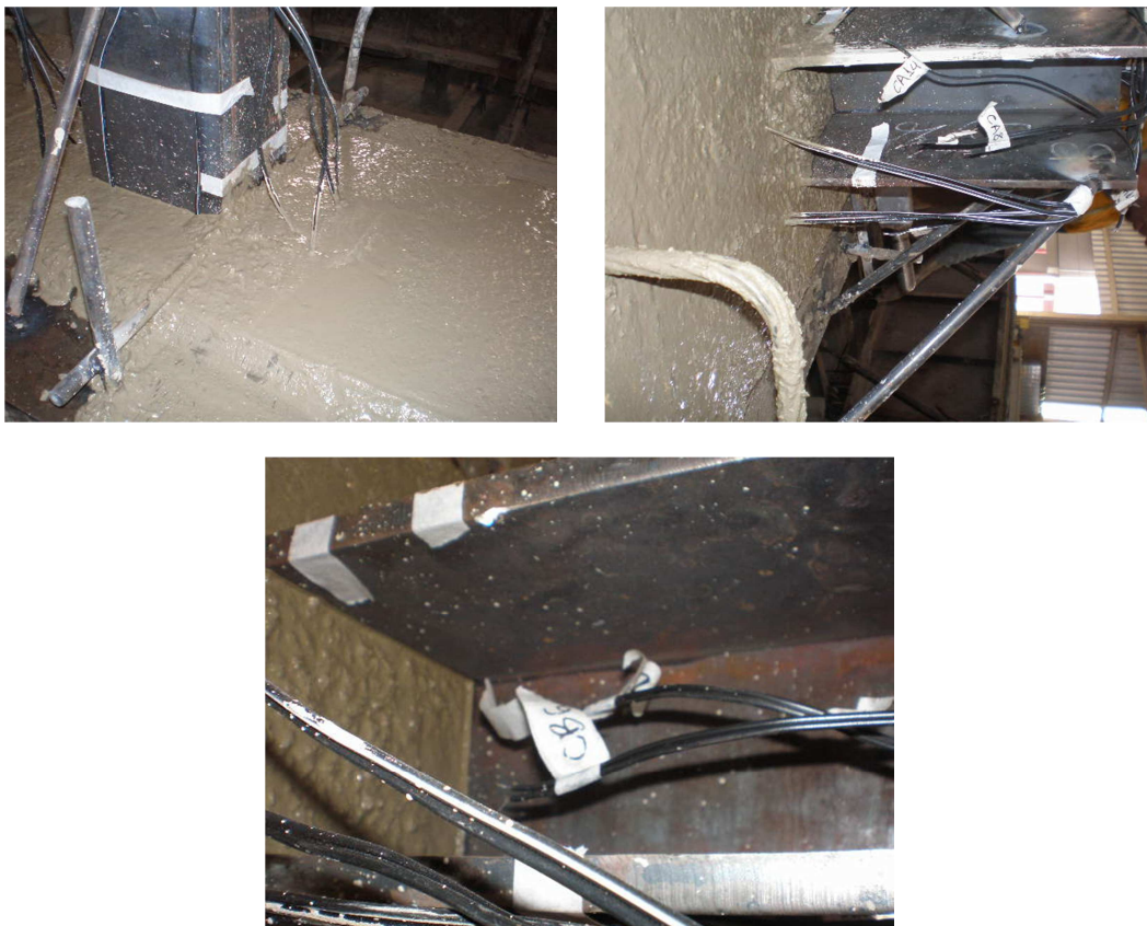
Figura 3.29 - Detalhe da concretagem dos pilares pré-moldados.
