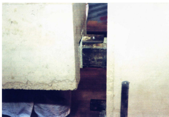
Figura 2.31 - Montagem do consolo vazado parafusado em uma das amostras ensaiadas [GORGUN (1997)].
