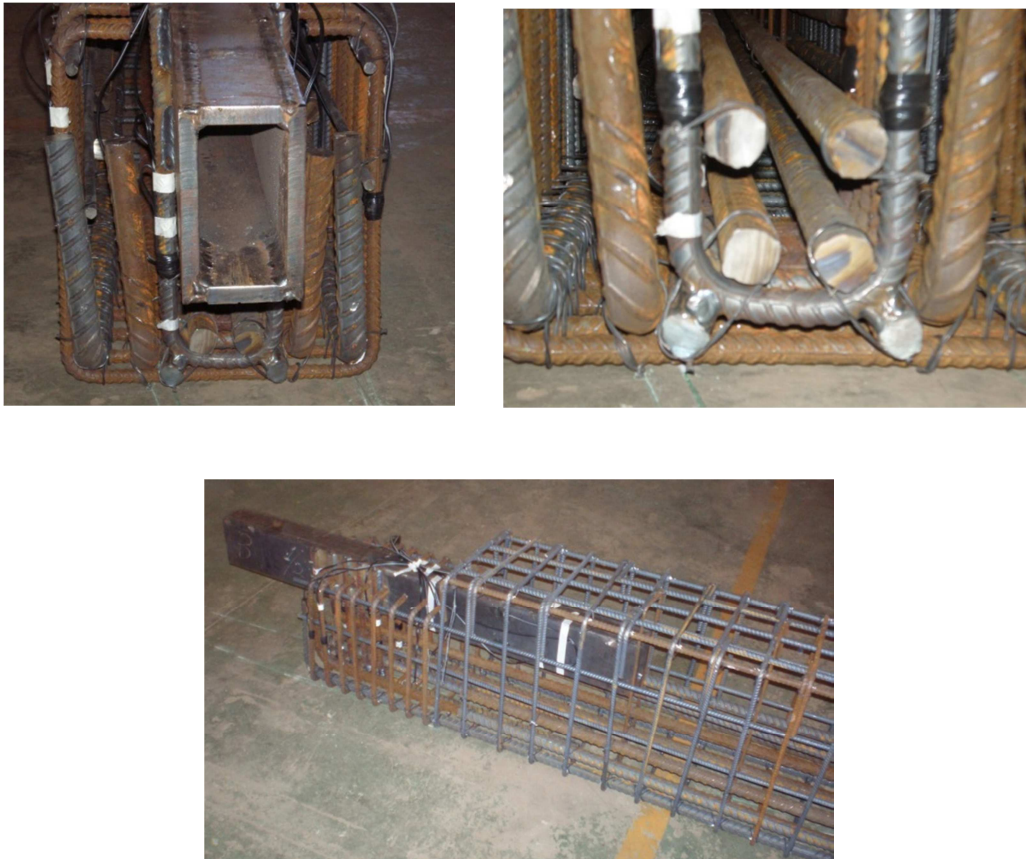
Figura 3.20 – Montagem da fôrma e armação da viga pré-moldada – Parte I.
