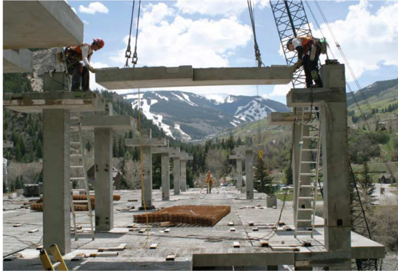
Figura 2.53 - Laje-viga pré-moldada sendo colocada na posição do consolo [Hanlon; Fernandez; Dolan (2009)].
