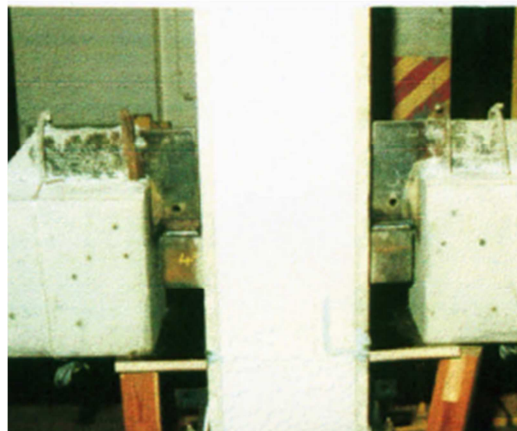
Figura 2.26 - Placa soldada no consolo após a montagem [GORGUN (1997)].
