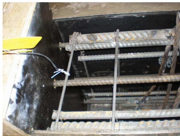
Figura 3.25 – Montagem da fôrma e armação dos pilares pré-moldados.
