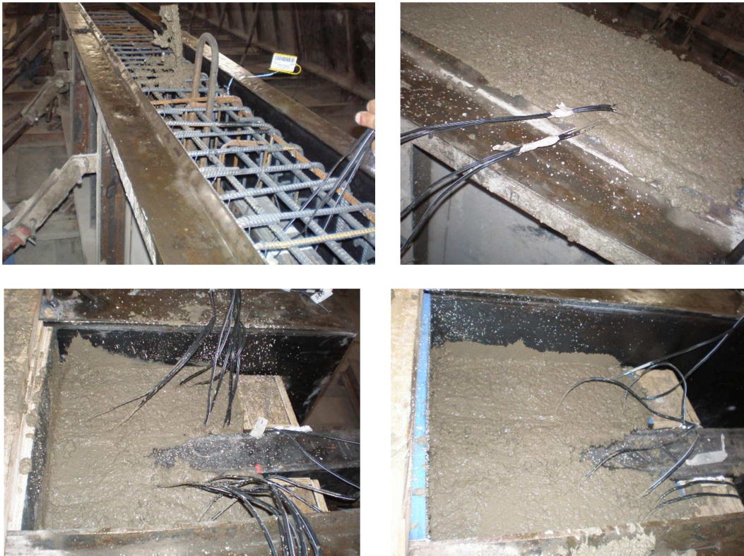
Figura 3.28 - Detalhe da concretagem da viga pré-moldada.
