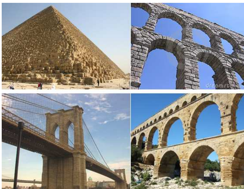
Figura 1.1 – Exemplos de construções em alvenaria estrutural (Silva, 2010; Dreamstime, 2012; Theredlist, 2012; Matteogiuffrida, 2012).
