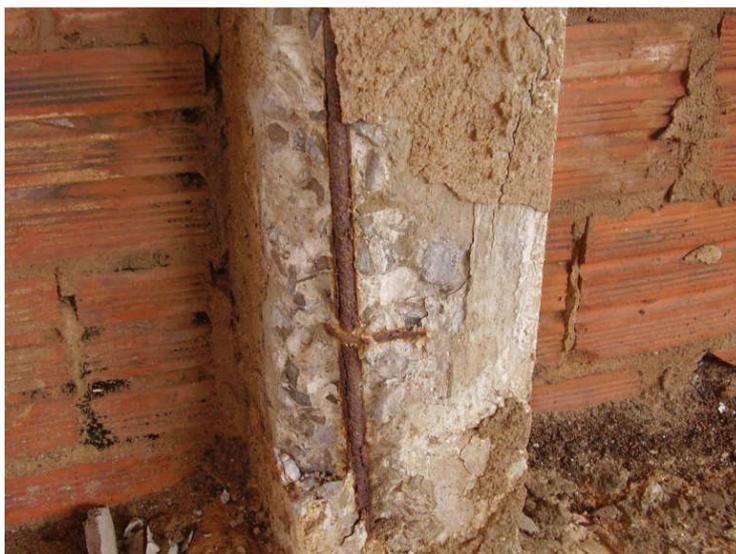
**Figura 1.1 - Corrosão da armadura de pilar**
