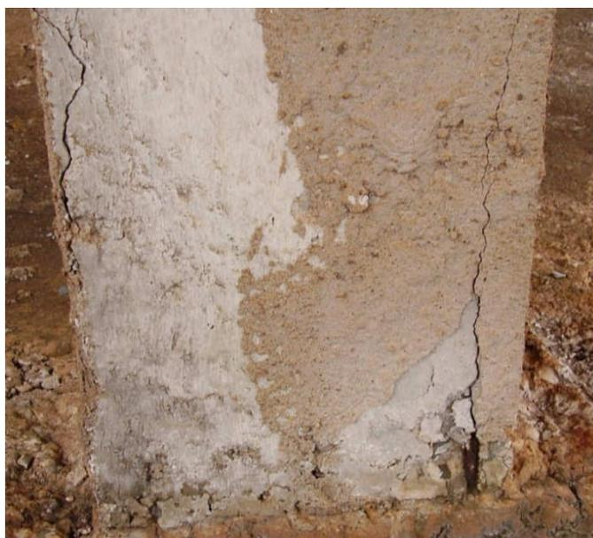
**Figura 4.8 - Fissuração longitudinal do concreto de cobertura em pilar**
