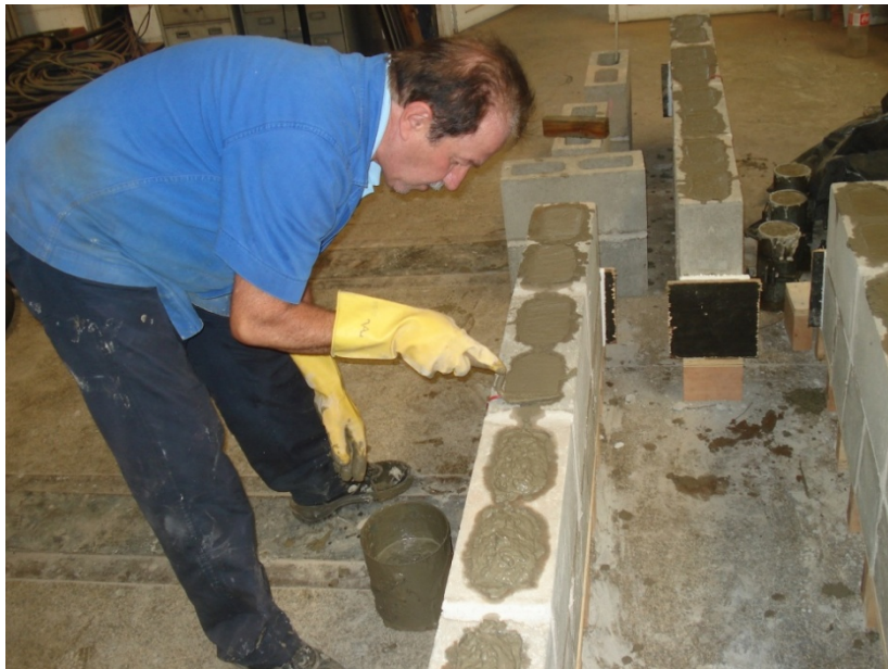
Figura 3.29 - Acabamento das vigas.
