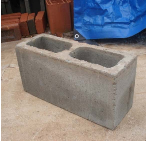
Figura 3.31 - Bloco vazado de concreto.
