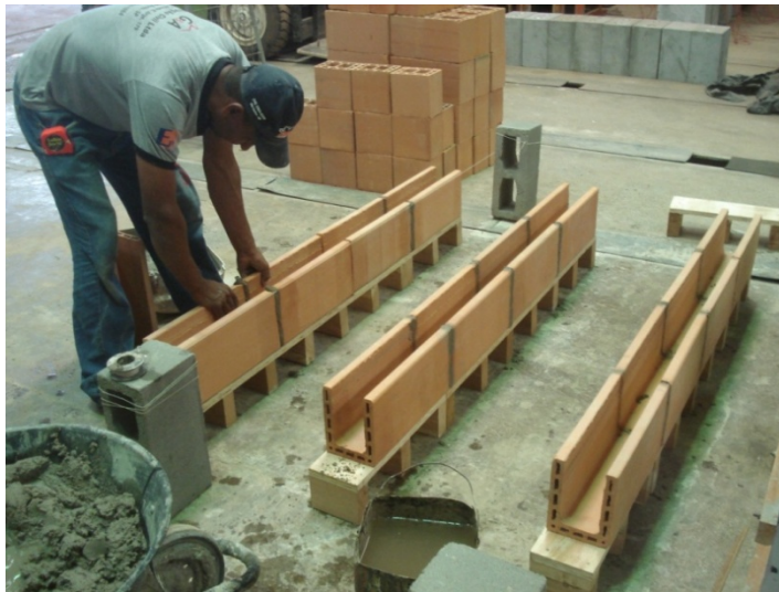
Figura 3.27 - Assentamento das vigas de blocos cerâmicos.
