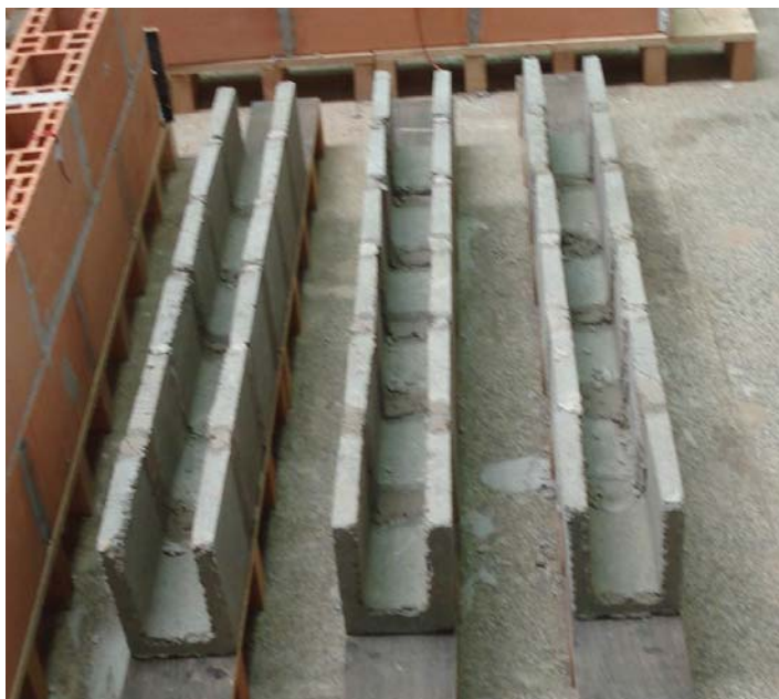
Figura 3.28 - Assentamento das vigas de blocos de concreto.
