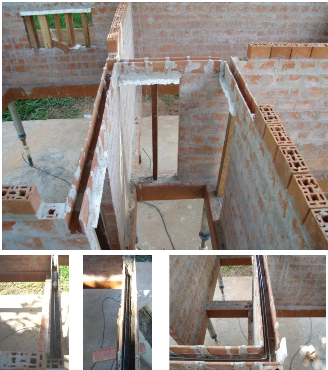
Figura 6. 26 – Detalhes da execução de vergas e contravergas, para os vão de janelas e portas do modelo físico reduzido.
