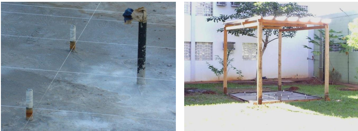
Figura 6. 12 – Detalhes do radier do modelo físico reduzido e da cobertura provisória em madeira e telhas metálicas.
