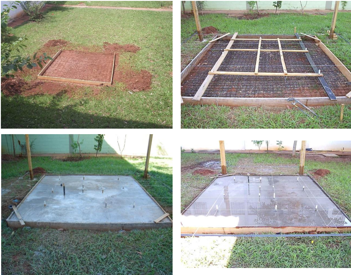
Figura 6. 11 – Detalhes do radier do modelo físico reduzido.
