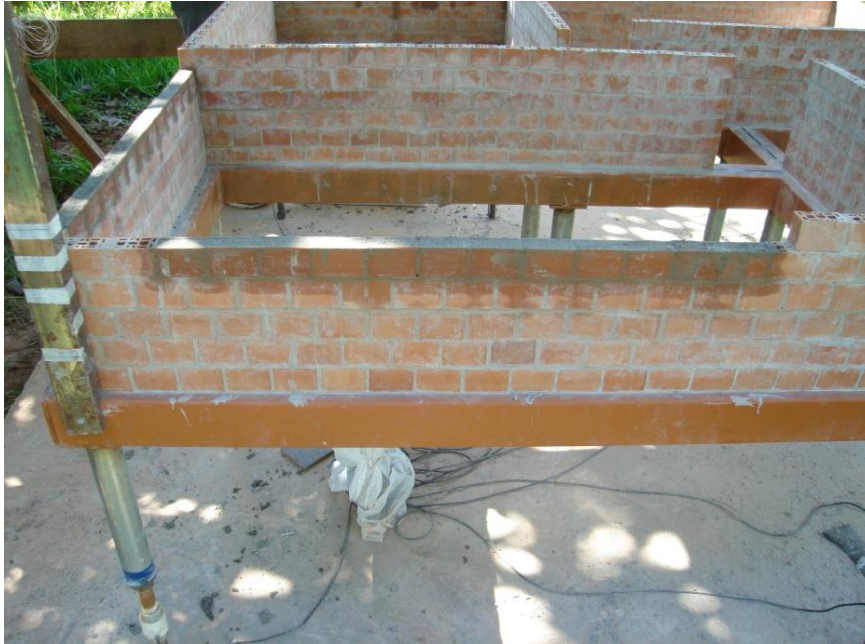
Figura 6. 24 – Detalhes das contravergas grauteadas no primeiro pavimento do modelo físico reduzido.
