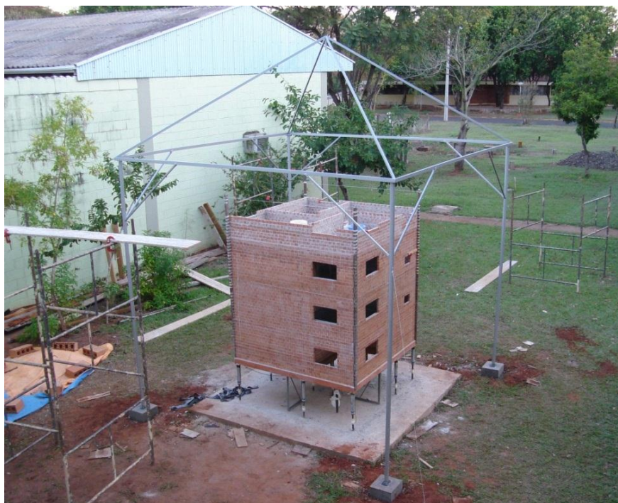
Figura 6. 33 – Detalhes da construção do quarto pavimento do modelo físico reduzido.
