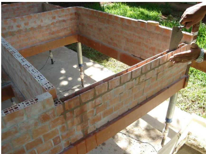
Figura 6. 23 – Detalhes da execução de contravergas no primeiro pavimento do modelo físico reduzido.
