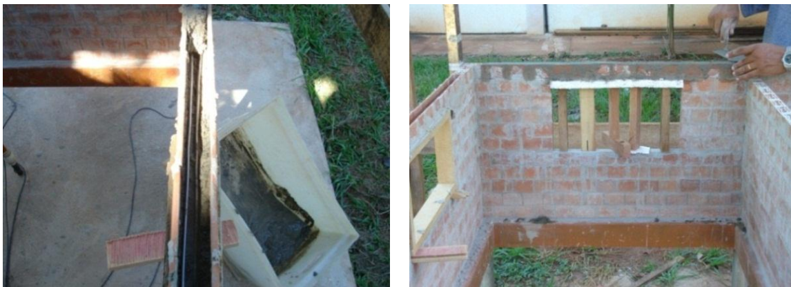
Figura 6. 25 – Detalhes da execução de vergas no primeiro pavimento do modelo físico.
