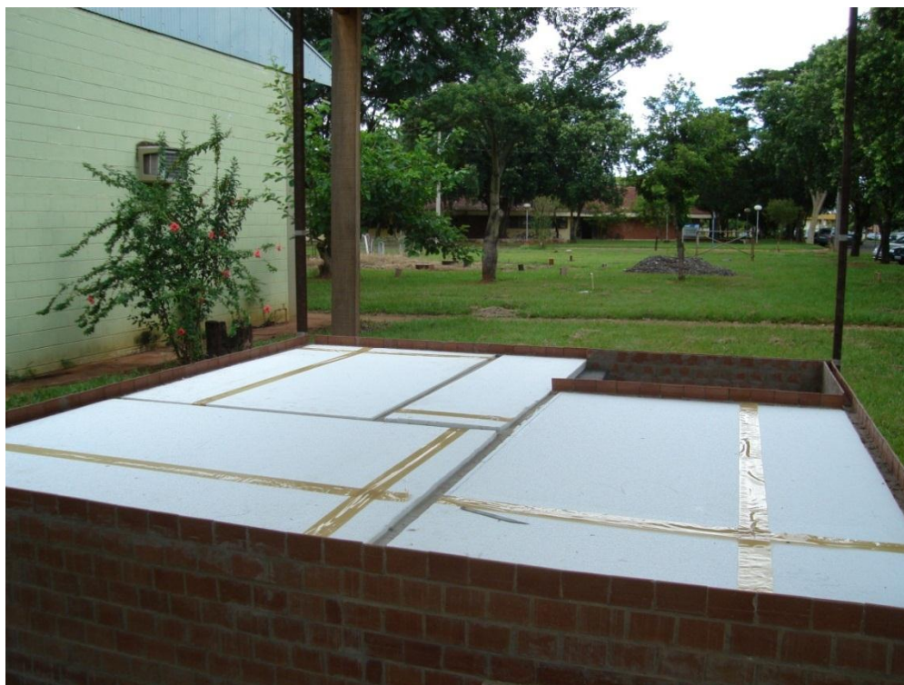
Figura 6. 30 – Detalhes da fôrma para as lajes do modelo físico reduzido.
