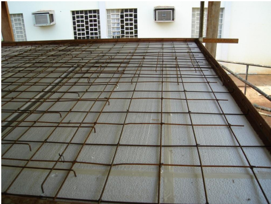
Figura 6. 32 – Detalhes da armadura negativa para as lajes do modelo físico reduzido.
