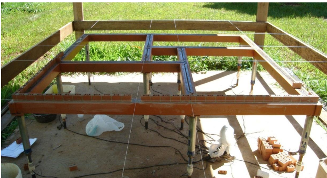
Figura 6. 22 – Detalhes da demarcação da primeira fiada do modelo físico reduzido.
