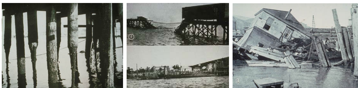
Figura 3.48. Danos causados por perfuradores marinhos em estruturas de madeira na Baía de São Francisco entre 1919 e 1921. Fonte: THOMPSON et al (2007)
