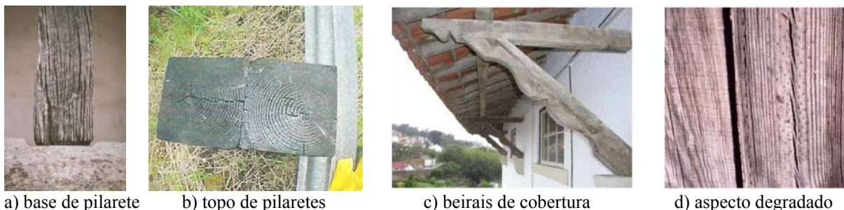
a) base de pilarete b) topo de pilaretes c) beirais de cobertura d) aspecto degradado Figura 3.65. Características visuais de diagnóstico de degradação pela ação da luz ultravioleta: a) Degradação pela ação da luz ultravioleta e intemperismo em estágio avançado, ARRIAGA et al (2002). b) degradação na extremidade das fibras em pilaretes de guarda-rodas. Observe nos anéis de crescimento a erosão menor na superfície de lenho inicial [ingl.: earlywood] entre o lenho tardio [ingl.: laterwood], em função da variação na coloração, BRASHAW et al (2012). c) e d) Alterações e fendas longitudinais da camada superficial da madeira devido a envelhecimento natural pela ação da luz ultravioleta e intemperismo, MACHADO et al (2009).
