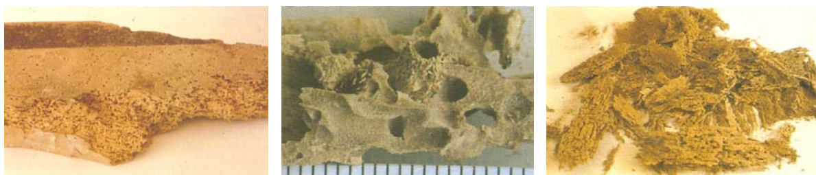
a) madeira deterioradas
