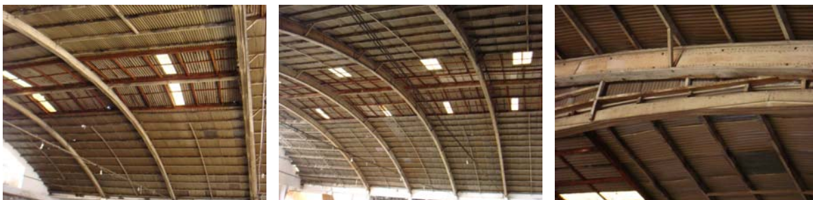
Figura 1.2. Exemplos de coberturas em arcos de madeira, com sistemas tipo “Hauff” existentes em Poços de Caldas – MG: arcos com cambotas de tábuas e vigas caixão com compensados. Fonte: BRITO et al (2014)
