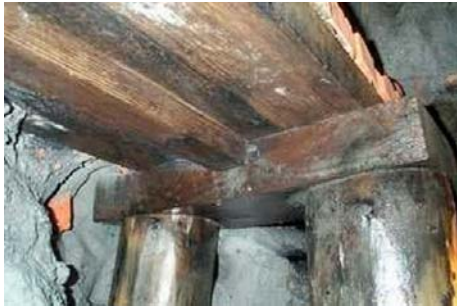
a) Estacas em Amsterdam em bom estado.
