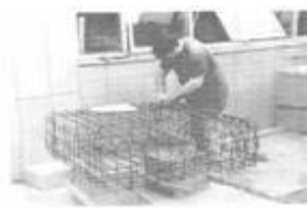
Montagem armadura
