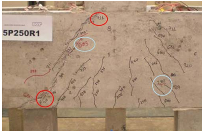
Figura 4.22 – Evolução de fissuras inclinadas no modelo B115P250R1
