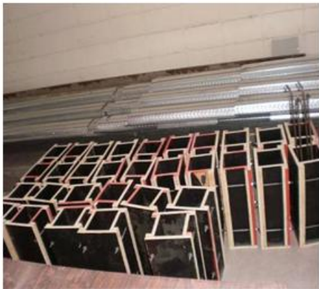
Fôrmas de estacas
