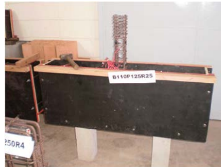
Fôrma do bloco com armadura posicionada
