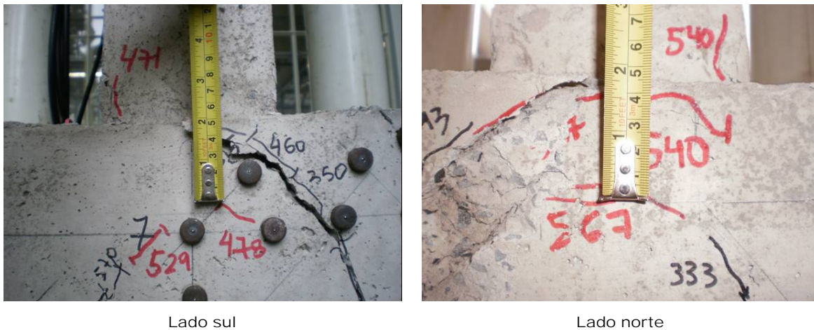
Figura 4.12 – Medida da altura até onde houve propagação da fissura inclinada B110P125R25
