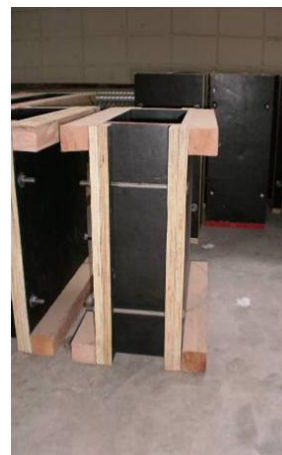
Detalhe de travamento em fôrma de pilar
