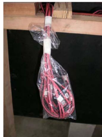
Fios de extensômetros protegidos
