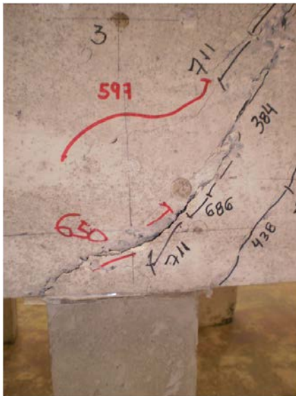
Região da estaca face sul
