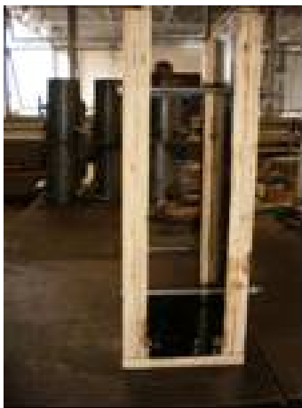
Preparação de fôrmas e corpos-de-prova
