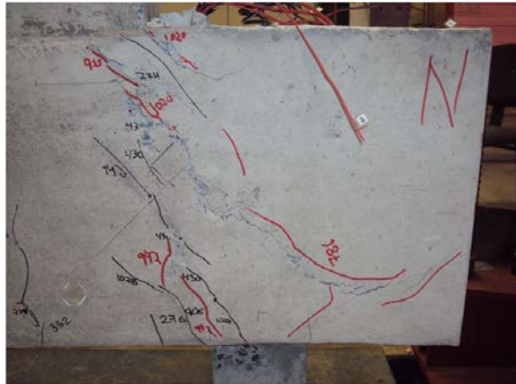
Figura 4.65 – Fissuras no pós-pico B127P500R1
