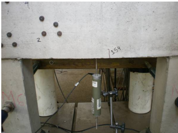
Primeira fissura anotada
