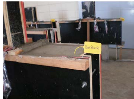
Detalhe da identificação
