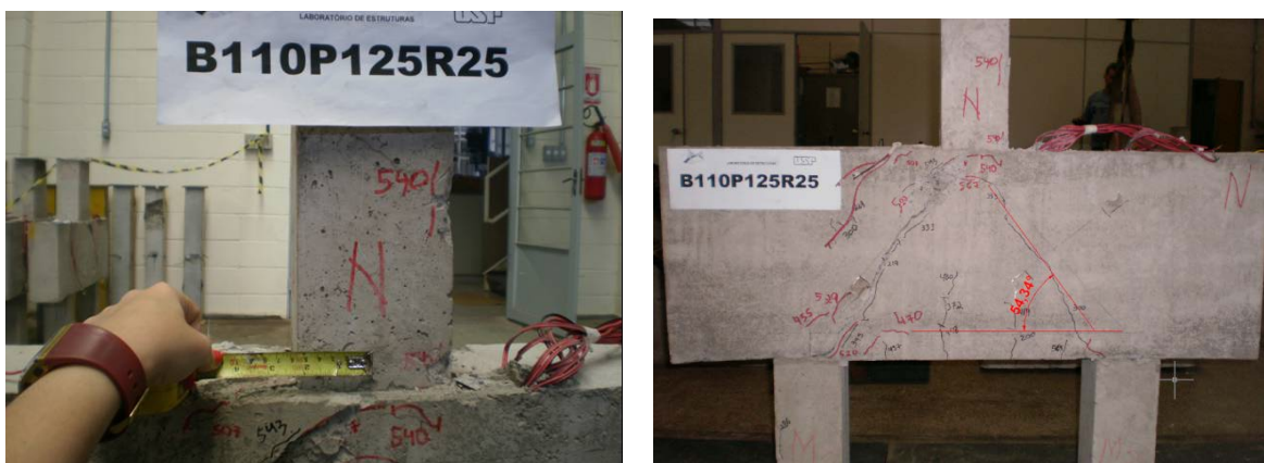
A - Distância da fissura principal até a lateral do pilar
