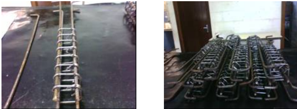
Figura 3.14 – Montagem das armaduras de estacas
