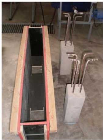
Fôrmas e estacas a serem posicionadas
