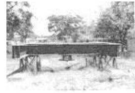
Montagem de viga de reação
