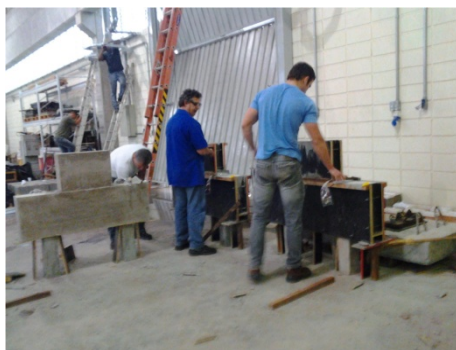
Retirada das fôrmas
