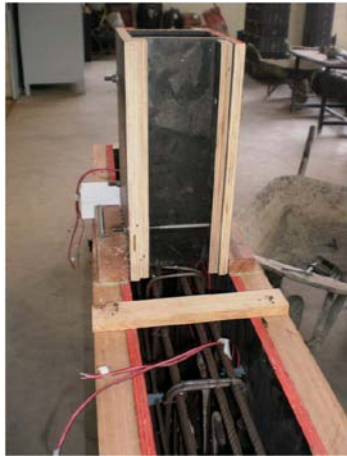
Colocação de fôrmas de pilares e travamento de fôrmas dos blocos
