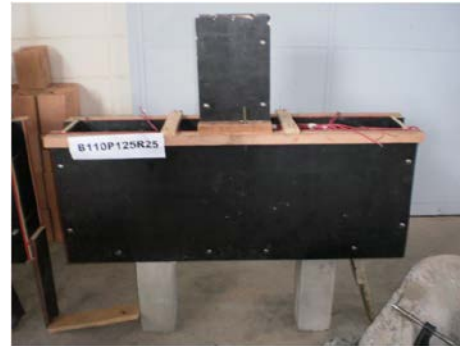
Fôrma do bloco com travamento e fôrma de pilar posicionado
