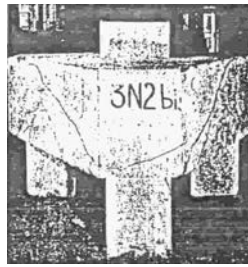
Bloco sobre três estacas
