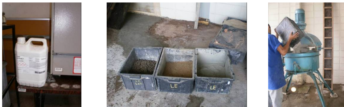
Materiais utilizados e confecção de mistura em betoneira
