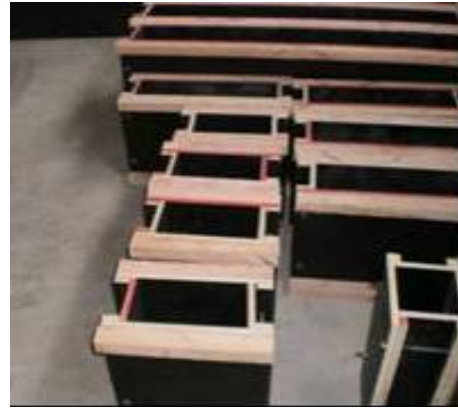
Fôrmas de pilares
