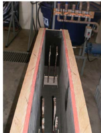
Fôrmas de blocos sobre as estacas
