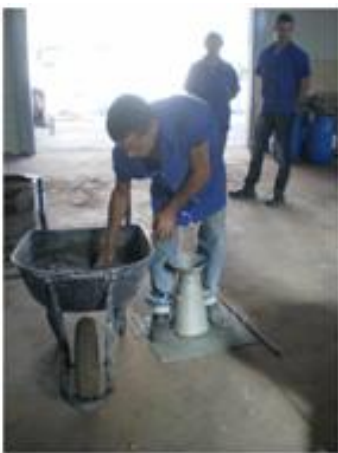
Preenchimento em camadas
