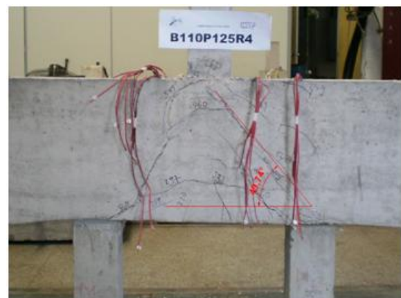
B - Inclinação da fissura medida no local
