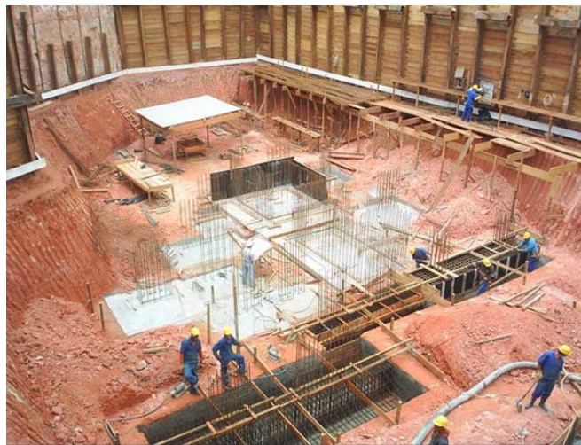
Figura 1.1 – Construção de fundações em edifícios ( http://www.geodactha.com.br )
