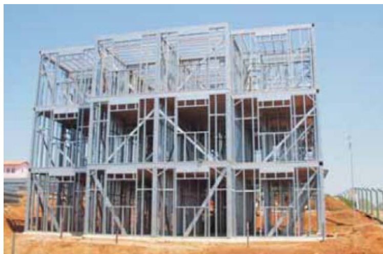
Figura 1.2: Edificação construída no sistema Light Steel Framing. Fonte: Revista Arquitetura & Aço, CBCA.
