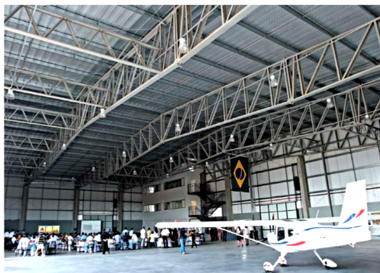
Figura 1.1: Hangar do Aeroporto de Amarais, Campinas – SP. Fonte: Revista Construção Metálica, n. 94, ABCEM
