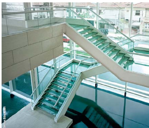
Figura 1.3: Escada do edifício multifuncional do Centro Brasileiro Britânico. Fonte: Revista Arquitetura & Aço, n.15 - CBCA.
