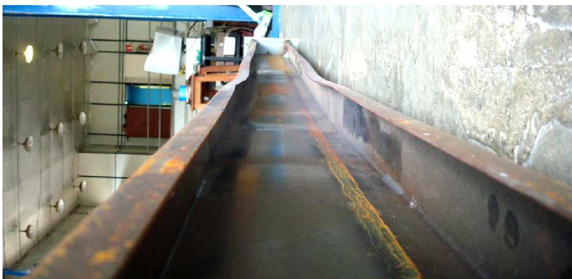
Figura 4.30: Deformações nos elementos do perfil I enrijecido após o ensaio termoestrutural.
