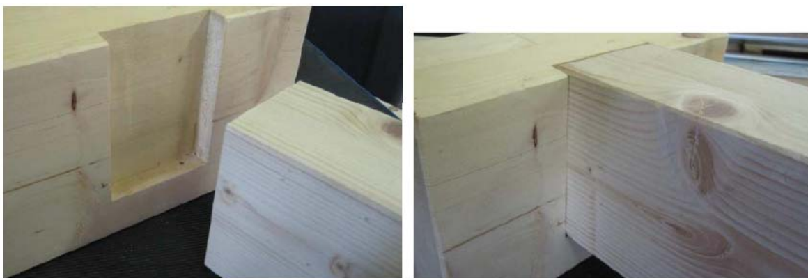
Figura 8 - Ligação em entalhe (Rothoblass 2012)
