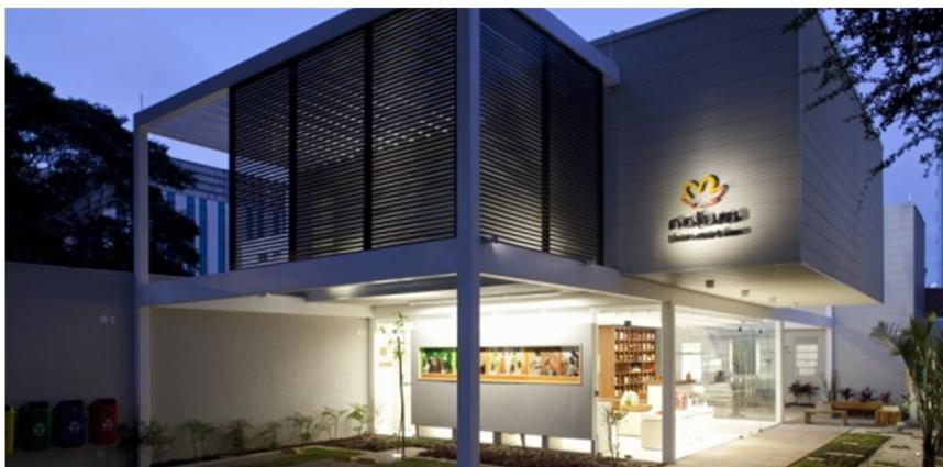
Figura 2.6 – Sistema estrutural com pórticos rígidos.
