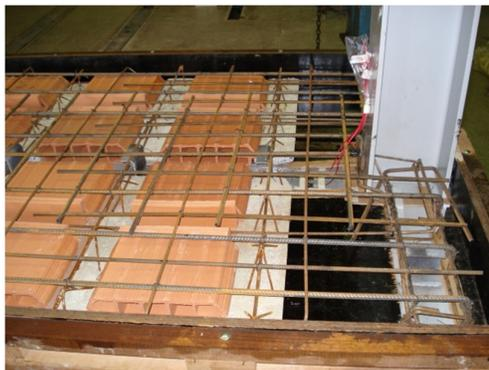
c – Laje pré-fabricada.
