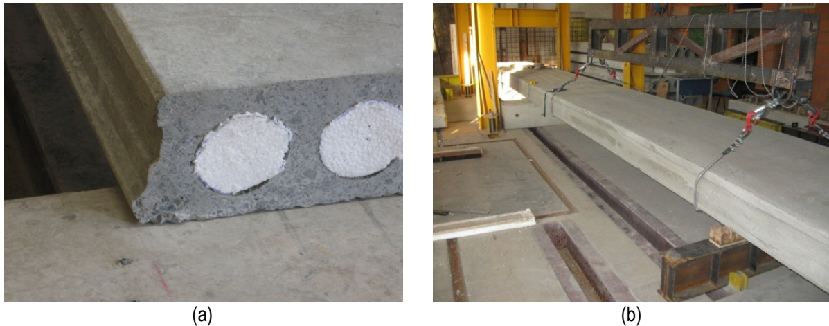
Figura 5.6 – Aspectos gerais de montagem: (a) Alvéolos vedados por isopor na região do apoio interno; (b) Montagem das lajes nos apoios.
