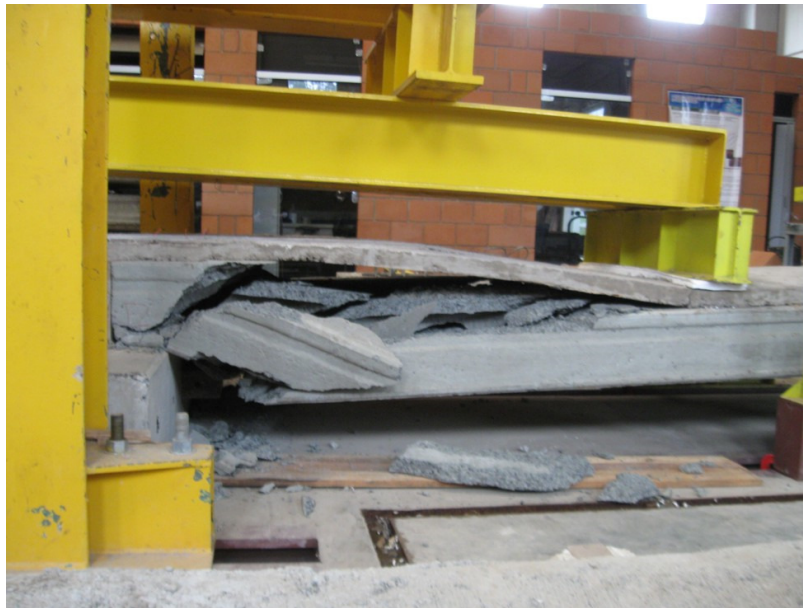
Figura 5.38 – Vista lateral da laje que sofreu ruptura no EM2. Laje da esquerda com relação ao lado de referência. Foto tirada no lado oposto.
