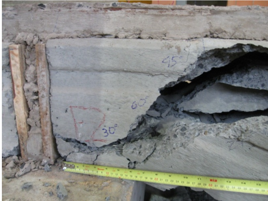
Figura 5.42 – Vista lateral de EM2 após a ruptura, mostrando a inclinação das fissuras. Com relação à face inferior da laje, a fissura começa com 30° e depois altera para 60° e, por fim, para 45° até atingir a interface laje-capa. Foto tirada do lado oposto.
