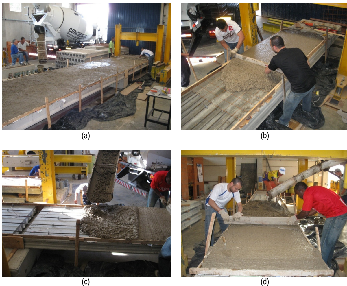
Figura 5.10 – Concretagem dos modelos: (a) EM1 – 17/02/2012; (b) EM2 – 20/06/2012; (c) EM3 – 26/07/2012; (d) EM3 – 26/07/2012.
