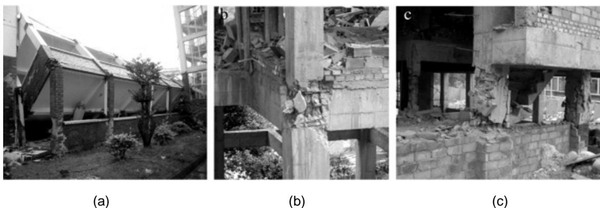
Figura 1.4 – Comportamento de estruturas de concreto armado quando sujeitas a ações cíclicas : a) Xuankou Middle School na cidade de Yingxiu, China; b) Colapso de ligação viga-pilar externo; c) colapso de pilar curto. Fonte: Zhao, Taucer e Rossetto (2009)
