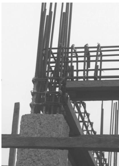
Figura 1.1<sup>1</sup> – Congestionamento de armaduras na ligação viga pilar
