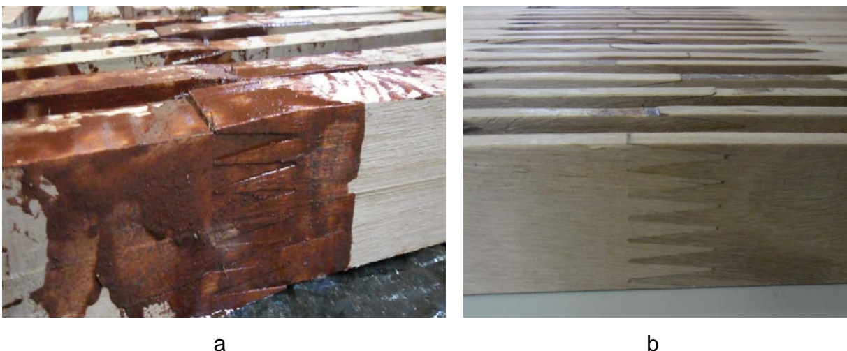
Figura 3.17 - Detalhe da emenda dentada com Cascophen (a) e corpos de prova isentos de defeitos com emenda para ensaio de tração após da usinagem (b).
