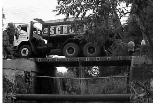
Figura 35 - Veículo posicionado na ponte, para prova de carga. (Fonte: Arquivo do LaMEM).
