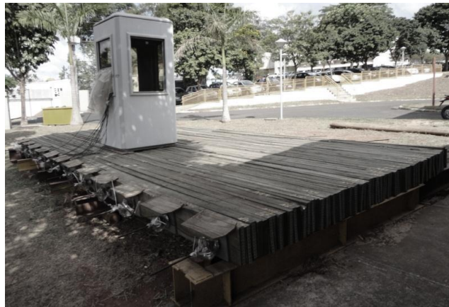
Figura 46 - Tabuleiro protendido com as células de carga.
