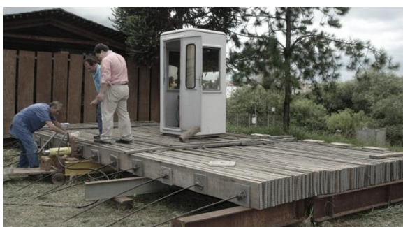
Figura 41 - Protensão do tabuleiro realizada por meio de uma bomba hidráulica (Fonte: Arquivo do LaMEM).
