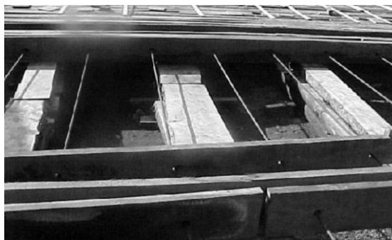
Figura 6 - Montagem inicial do tabuleiro laminado com barras de aço DYWIDAG (Fonte: Arquivo do LaMEM).
