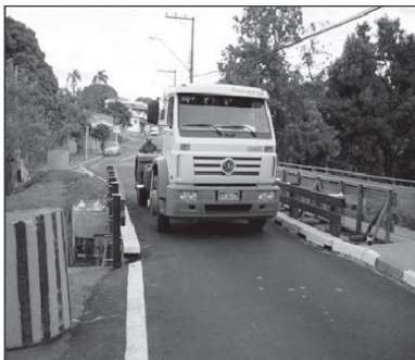
Figura 8 - Ponte Monjolinho localizada em São Carlos, SP (Fonte: Arquivo do LaMEM).
