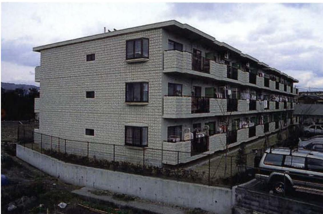
Figura 2.2 – Condição de um edifício com paredes pré-moldadas, após terremoto em Kobe, no Japão (GHOSH, 1995)
