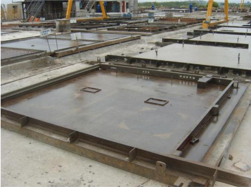
Figura 2.7 – Fabricação de painéis sobre superfícies planas.
