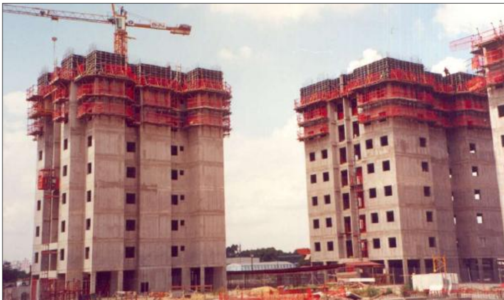
Figura 1.1: Edifícios de parede de concreto moldadas no local. (Fonte: www.abrasfe.org.br )
