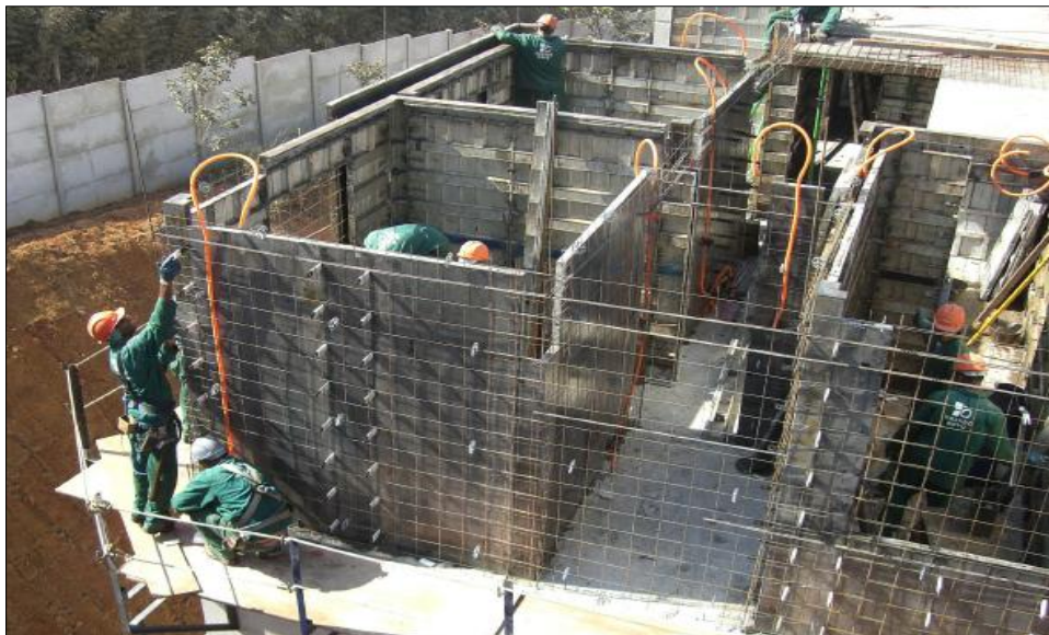
Figura 2.1: Aplicação do sistema de paredes de concreto. (Fonte: www.abcp.org.br )
