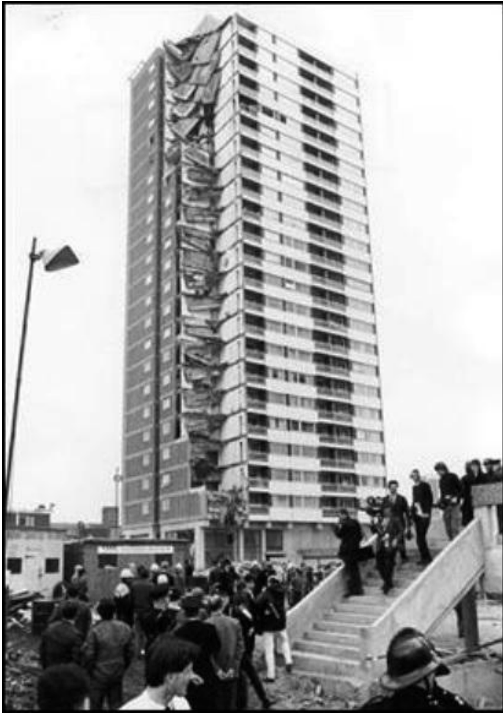
Figura 4.10: Edifício em Ronan Point, Londres [Fonte: Laranjeiras (2010)]
