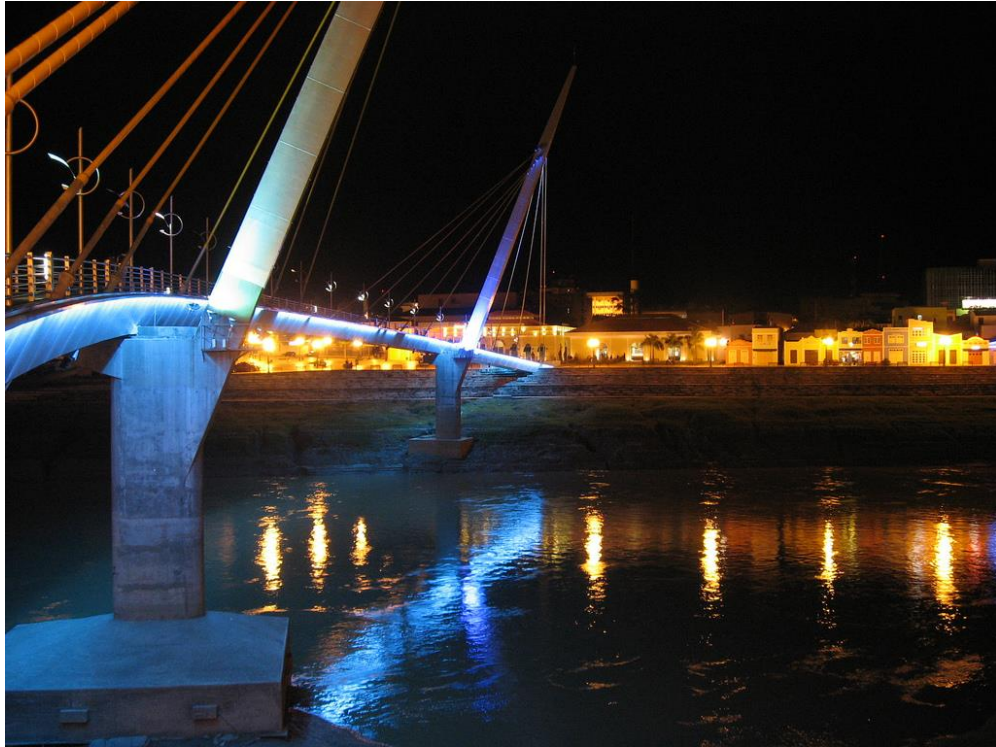
Figura 5 – Passarela Estaiada em Rio Branco, Acre
