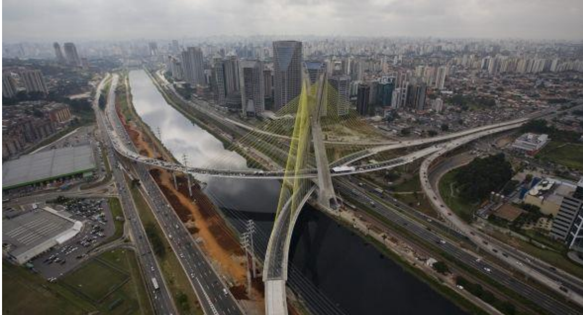
Figura 7 – Ponte Octavio Frias de Oliveira
