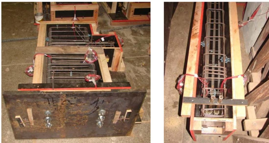
Figura 7.9 - Fôrma do pilar e da viga.
