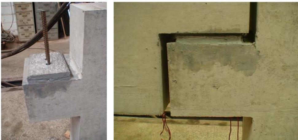
Figura 7.12 - Detalhes do posicionamento da almofada de apoio.
