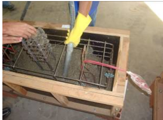
Figura 4. 24 – Concretagem dos blocos de fundação
