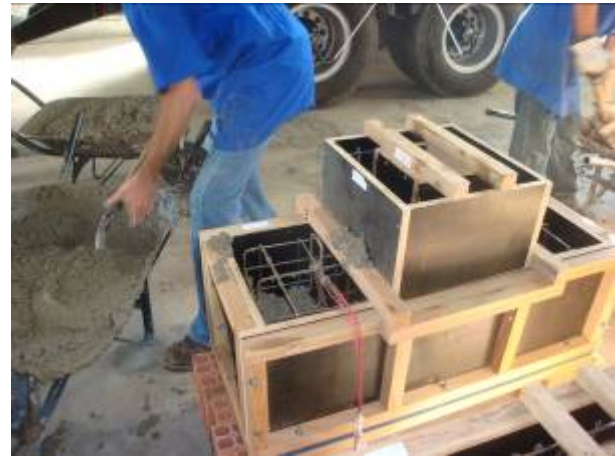
Figura 4. 25 – Concretagem dos blocos de fundação
