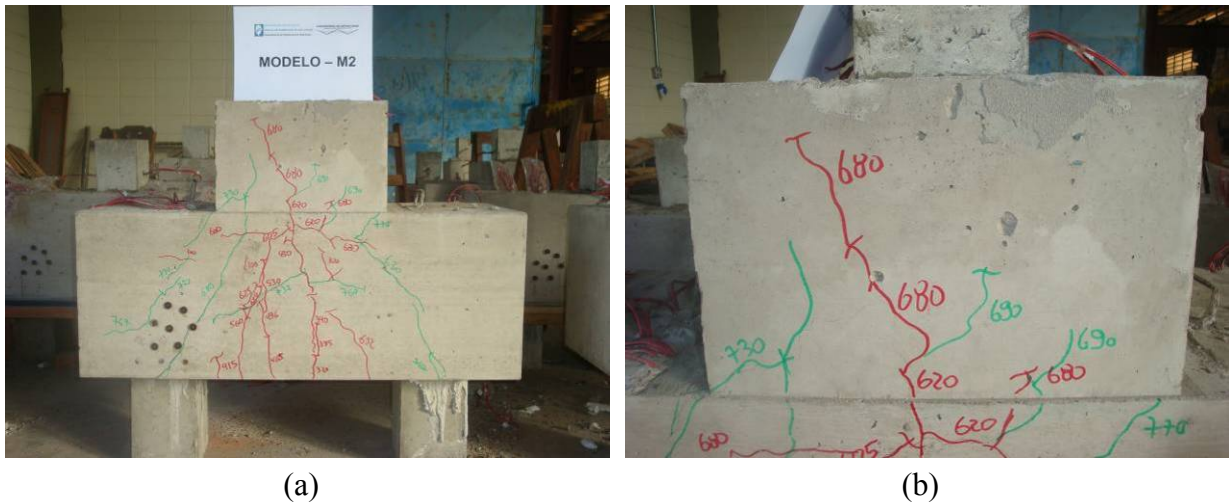
Figura 5. 23–Fissuras na face lateral e no cálice do Modelo M2
