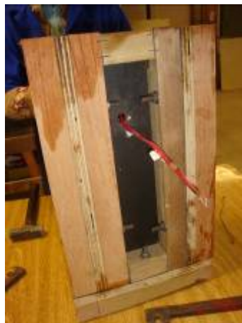
Figura 4. 30 – Fôrma e armação dos pilares
