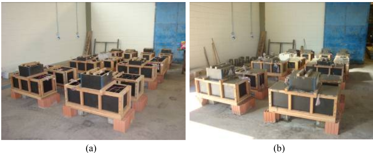
Figura 4. 28 – Blocos de fundação antes e após a etapa de concretagem
