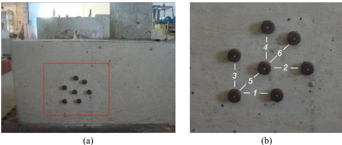
(a) (b) Figura 4. 49– Indicação das leituras de deformações no concreto dos blocos
