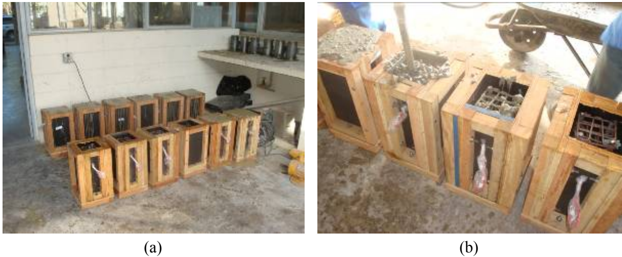
Figura 4.31 – Concretagem dos pilares
