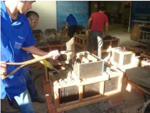
Figura 4. 25 – Concretagem dos blocos de fundação
