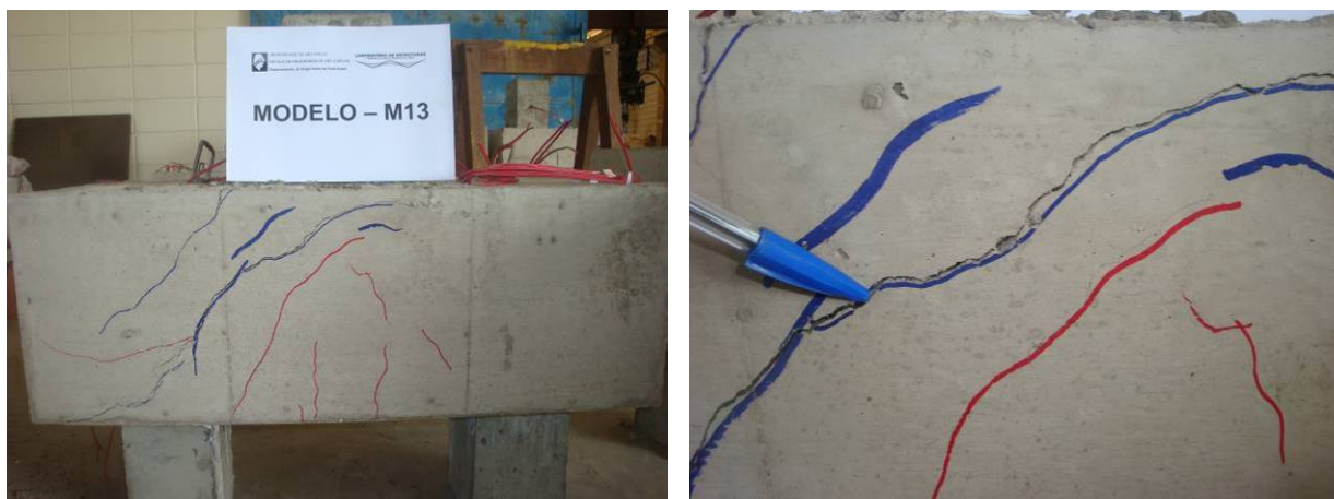
(a) (b) Figura 5. 113–Fissura diagonal na face oposta do Modelo M13
