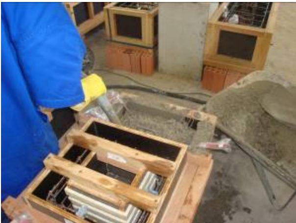
Figura 4. 24 – Concretagem dos blocos de fundação
