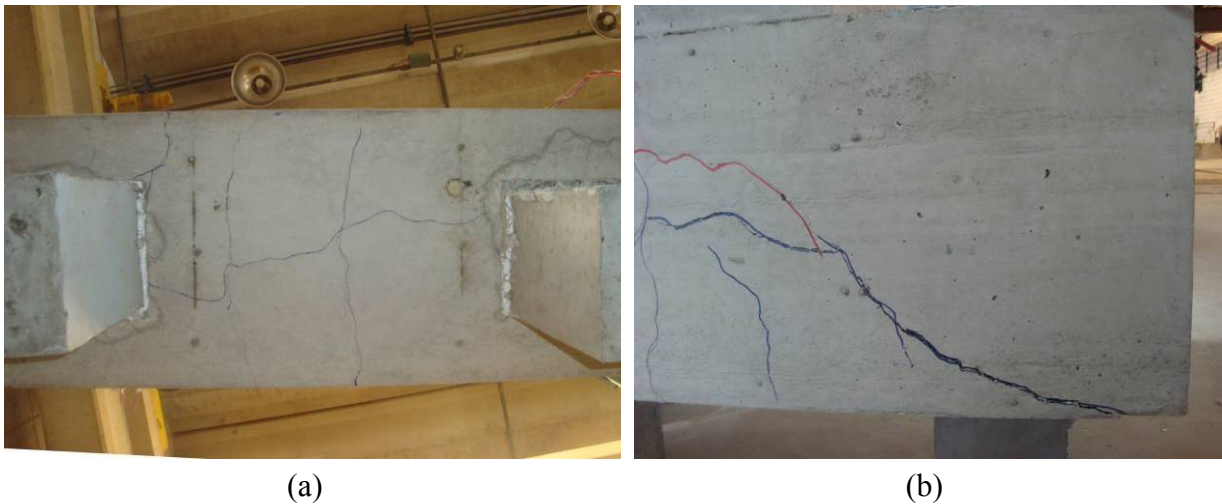
Figura 5.53–Fissuras na face inferior e lateral oposta do Modelo M4
