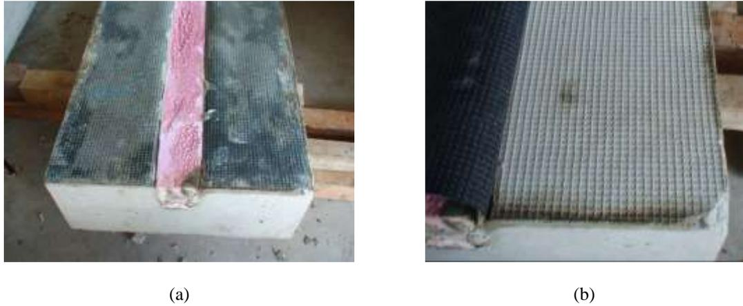
Figura 4-11 – Desforma da laje pré-moldada: (a) detalhe do EPS; (b) detalhe da rugosidade
